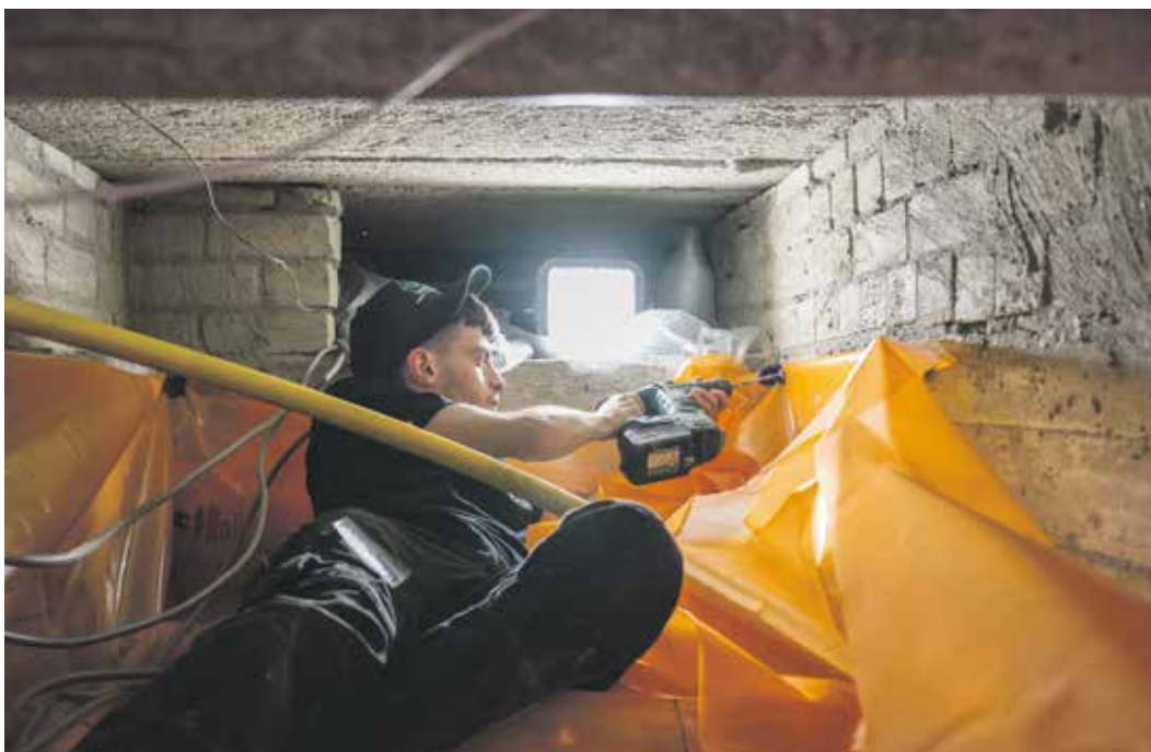
De monteur plaatst thermokussens in de kruipruimte onder de vloer.
