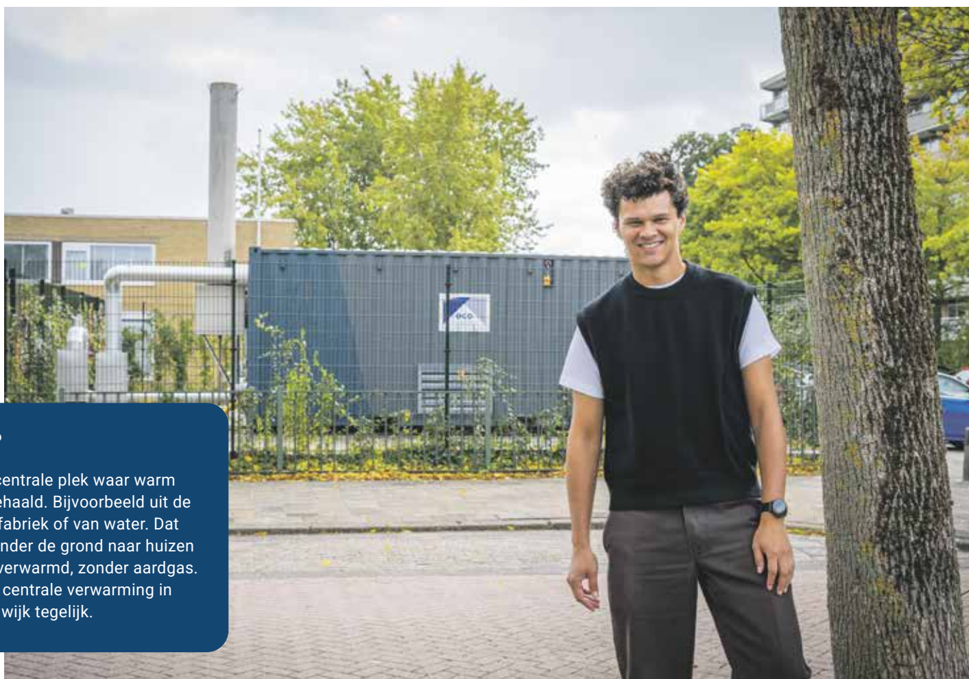
Casper bij het Tijdelijk warmte station (TWS) aan de Constantijn Huygenslaan in Papendrecht.
