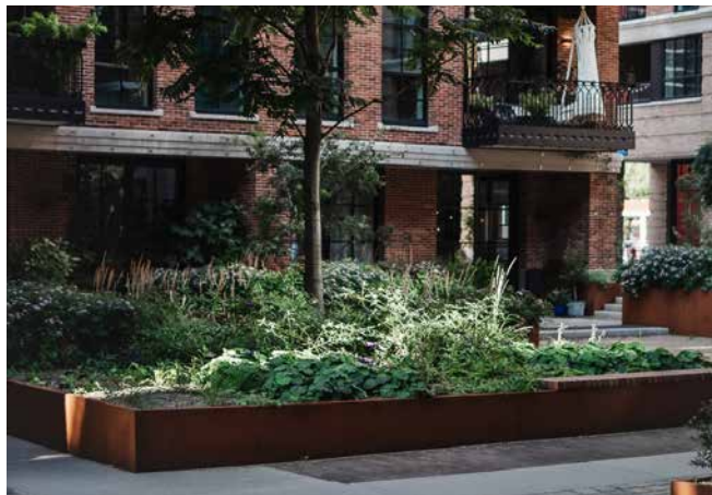
Plein gesitueerd bovenop een retentiedek
