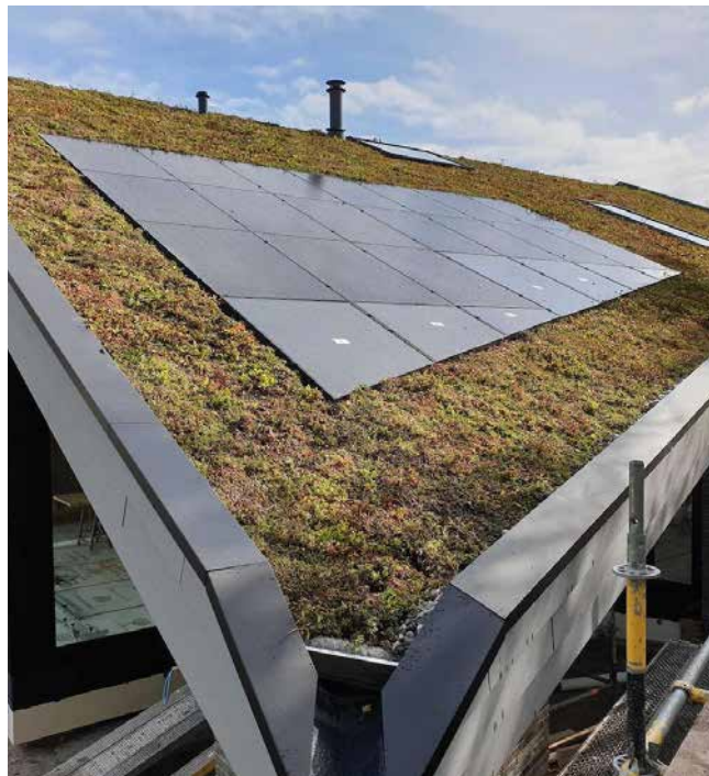
Schuin natuurdak gecombineerd met energieopwekking
