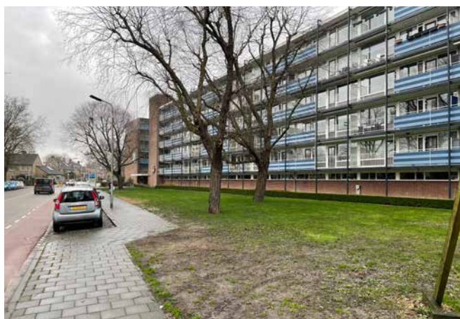
Aanzicht huidige bebouwing vanaf de Rembrandtlaan
