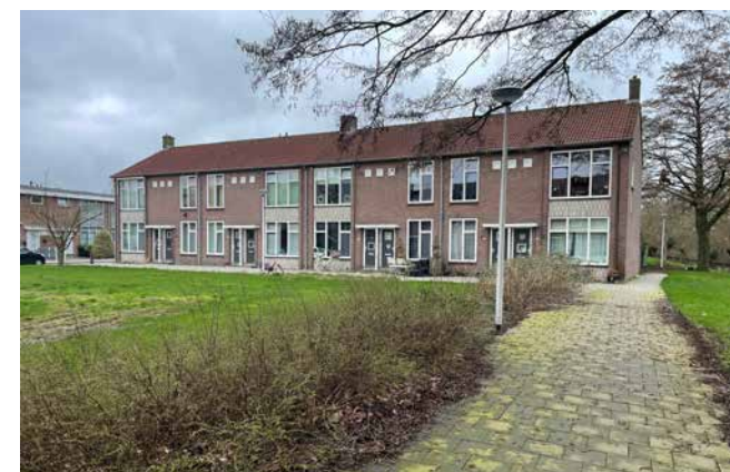
Bestaande bebouwing binnen het plangebied
