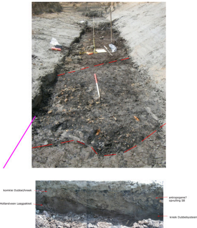
Afb. 9. Boven: de oostelijke, parallel aan de Dubbelgeul lopende kreek S8 met mogelijk antropogene opvulling, gezien in westelijke richting. In de jongste opvulling is veel baksteenpuin en een liggende, aangepunte paal te zien (links voor). De roze lijn geeft het zuid-profieldeel aan dat eronder is weergegeven.
