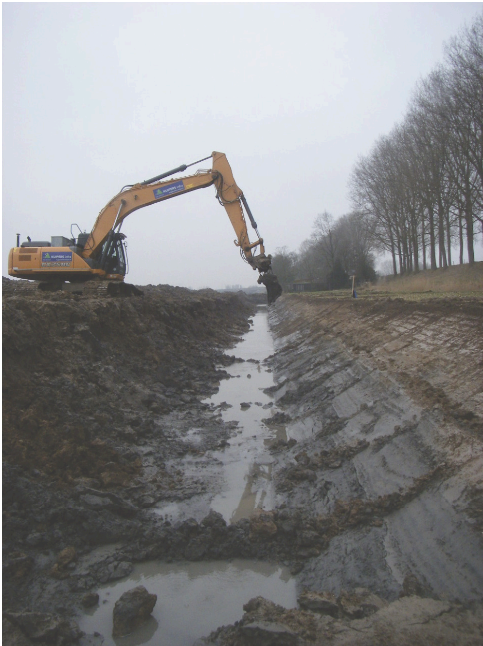
Aanleg van de, archeologisch begeleidwatergang in het kader van de realisatie van de Nieuwe Dordtse Biesbosch.
