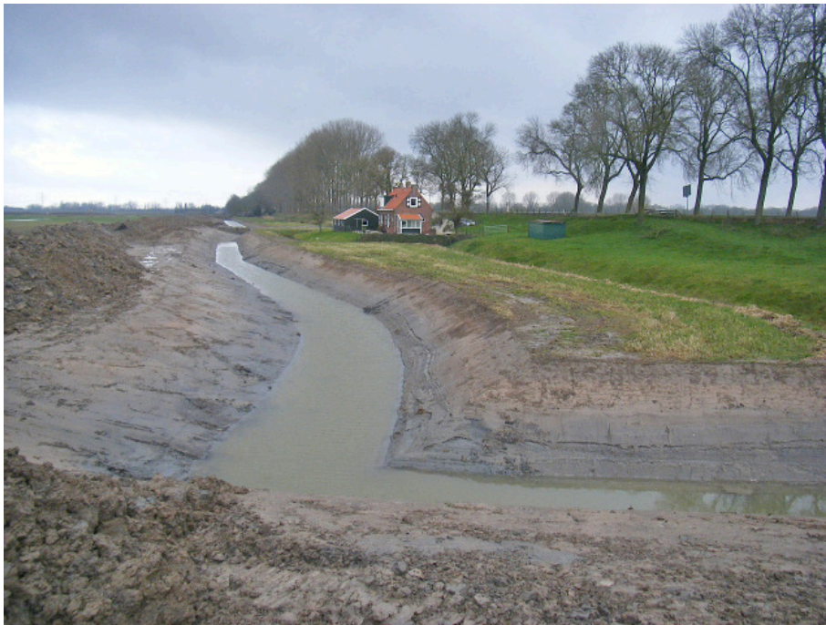
Afb. 3. Het afgeronde graafwerk ter hoogte van de Zeedijk 5 gezien vanaf de Van Elzelingenweg.
