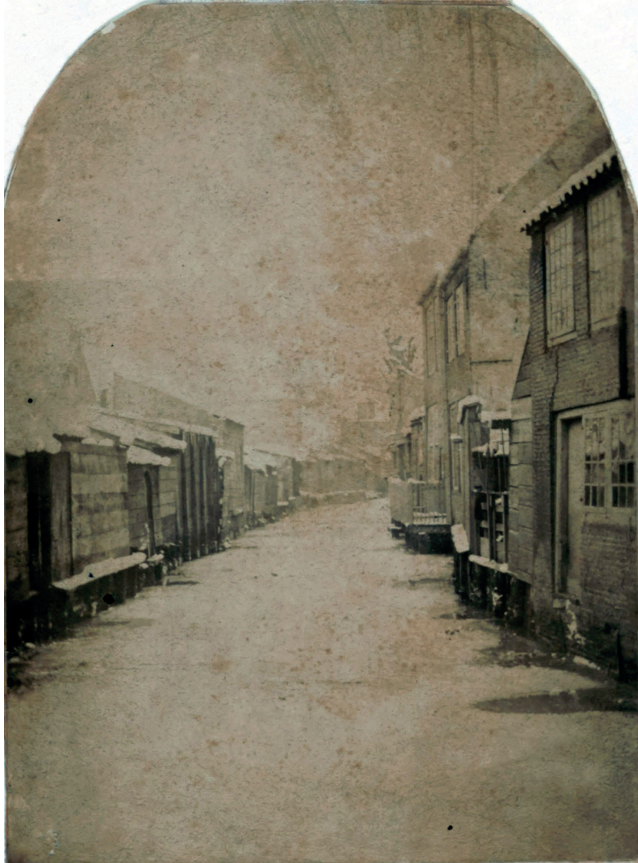
Afb. 14. De stadsgracht tussen de bebouwing aan de Lange Breestraat (rechts) en de Raamstraat (links) in de periode 1870-1880 (RAD inventarisnr. 552_310390). Aan de zijde van de Lange Breestraat lijken de meeste huizen met de bebouwing (hoge achterhuizen) door te lopen tot aan de binnengracht. Aan de zijde van de Raamstraat lijkt meer sprake te zijn van open achtererven met lage schuurtjes die tot aan de binnengracht lopen. De foto is genomen vanaf de Visstraat-Bagijnhof in zuidwestelijke richting over de binnengracht (voor het standpunt en zichtlijnen, zie afb. 12).
