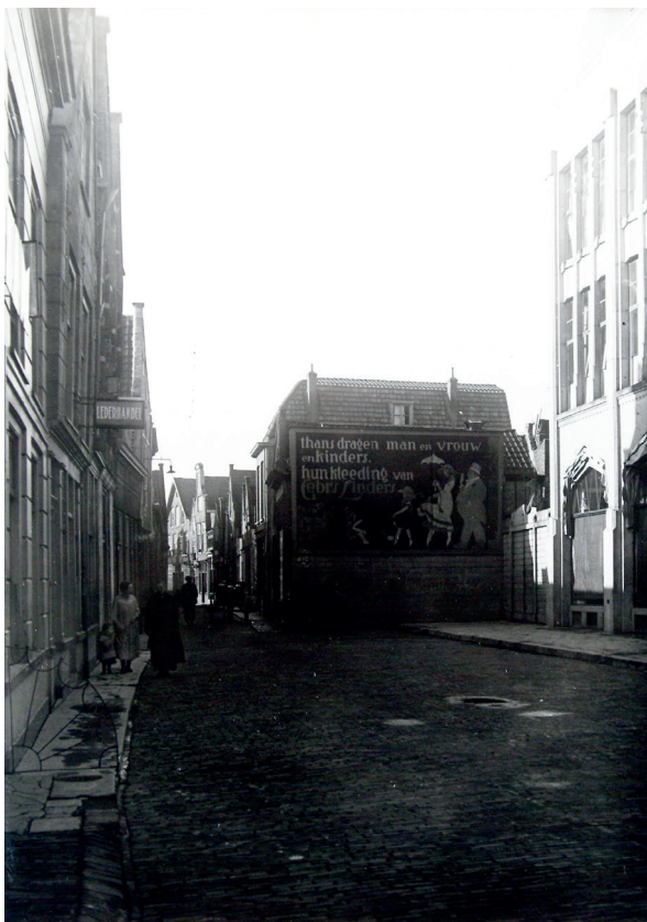
Afb. 18. De nog slechts deels verbrede Raamstraat in de periode 1923-1927, gezien vanaf de hoek Bagijnhof-Raamstraat in zuidwestelijke richting. Rechts is het nieuwe pand van het warenhuis KOFA Linders (het huidige Lindershuis, nu nog aanwezig) te zien. Daarachter is nog de oorspronkelijke bebouwing aan de Raamstraat binnen het plangebied te zien aan de smalle, oorspronkelijke Raamstraat (RAD inventarisnr. 555_16221).
