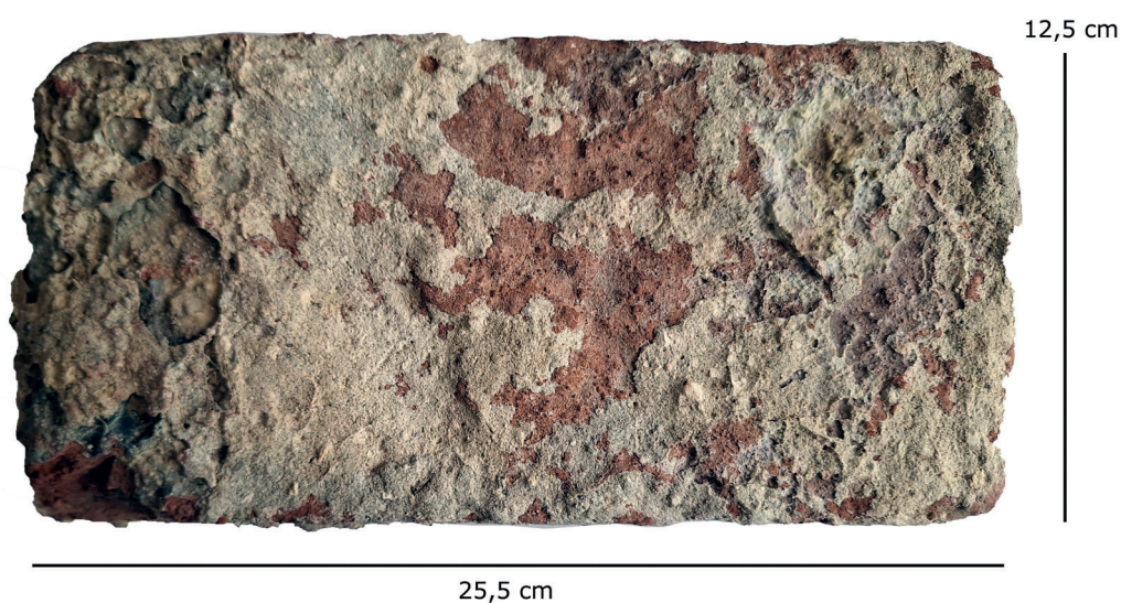
Afb. 13. Een voorbeeld van de gebruikte bakstenen in de kademuur van de doorsteek van de Nieuwe Haven naar de Wolwevershaven. Voor de locatie van dit muurwerk, zie afb. 14, linksboven (vnr. 1, Dorst 2024, vakteam erfgoed).
