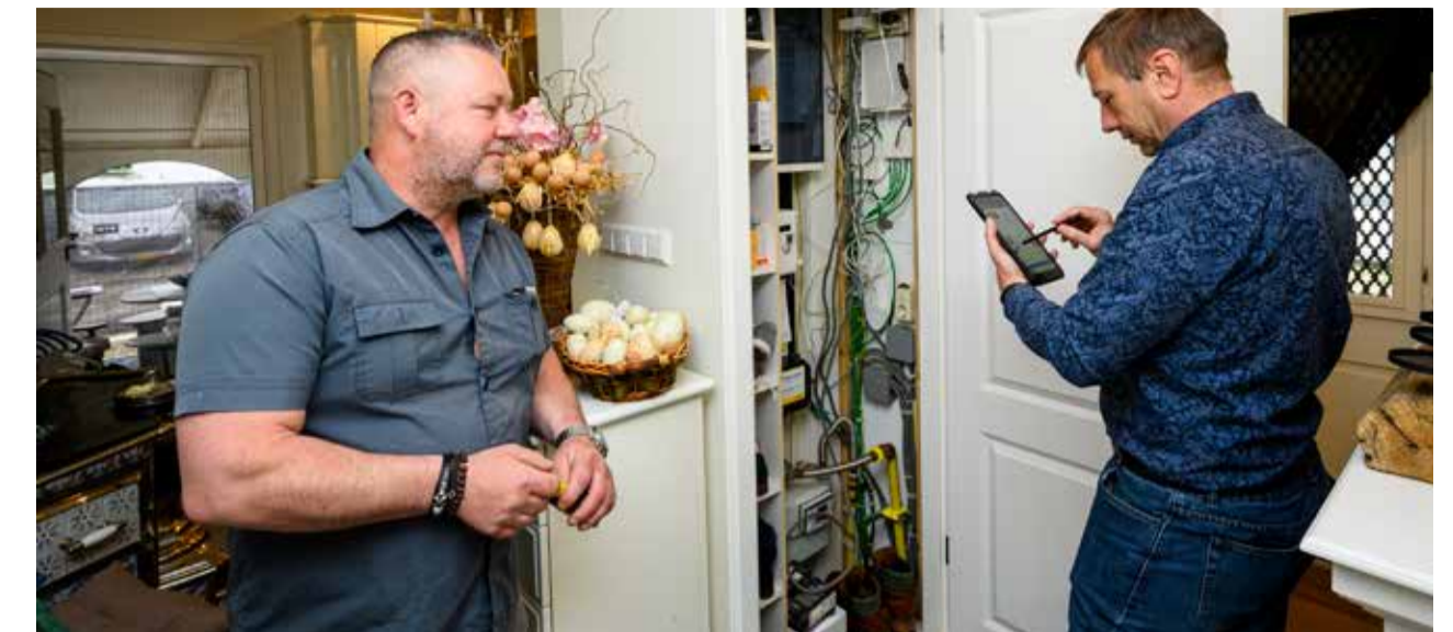
Voordat de woningeigenaren hun besluit namen, kregen zij een woningopname. Zo is duidelijk wat er in en rond huis moet gebeuren voor aansluiting op het warmtenet.
