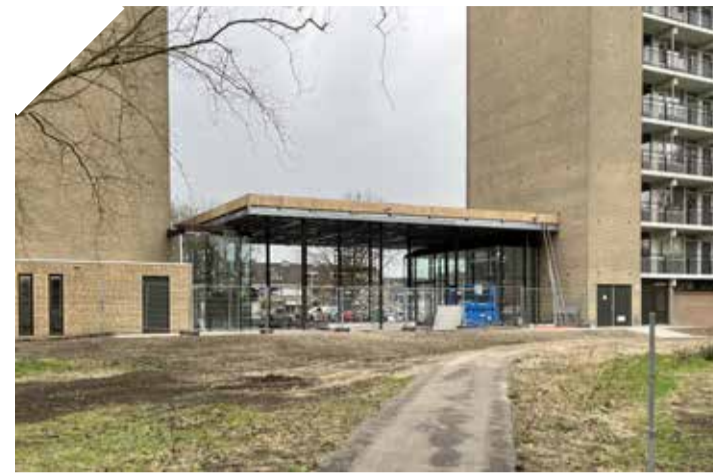
Ook de centrale hal van de Valkhof wordt vernieuwd.
