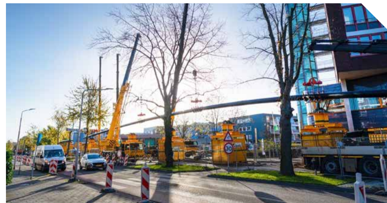
De aanleg van een warmtenet in een drukke straat als de Deltalaan betekent af en toe echt 'kunst- en vliegwerk' in de uitvoering.
