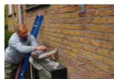
Gaatjes worden vakkundig gedicht
