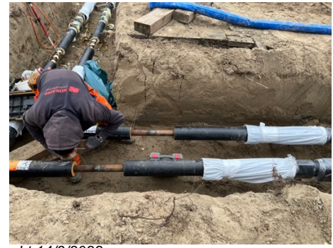
Isoleerder aan de slag bij aanleg warmtenet hoek Blaauwweg / Regenboogstraat Dordrecht 14/3/2022
