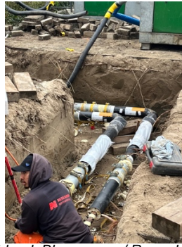
Isoleerder aan de slag bij aanleg warmtenet hoek Blaauwweg / Regenboogstraat Dordrecht 14/3/2022
