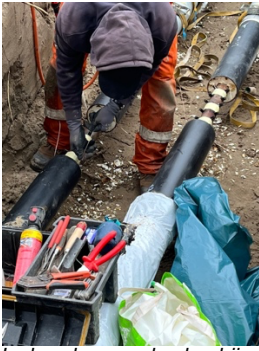
Isoleerder aan de slag bij aanleg warmtenet hoek Blaauwweg / Regenboogstraat Dordrecht 14/3/2022
