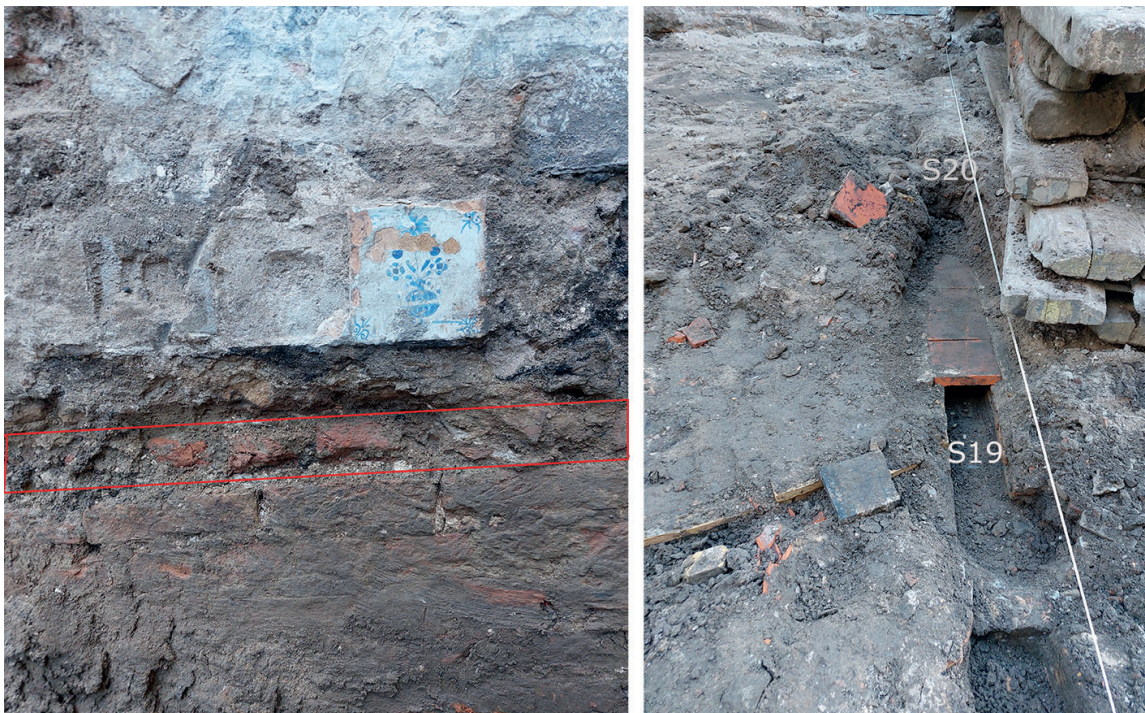
Afb. 13. Links: een deel van de oostelijke gevelmuur van het pand op perceel 142; rood omlijnd is de faseringsgrens van de oostgevel aangegeven. Het muurwerk hierboven dateert uit de 17 e eeuw (tegelwand S18) en het muurwerk daaronder uit ten minste de 16 e eeuw.
