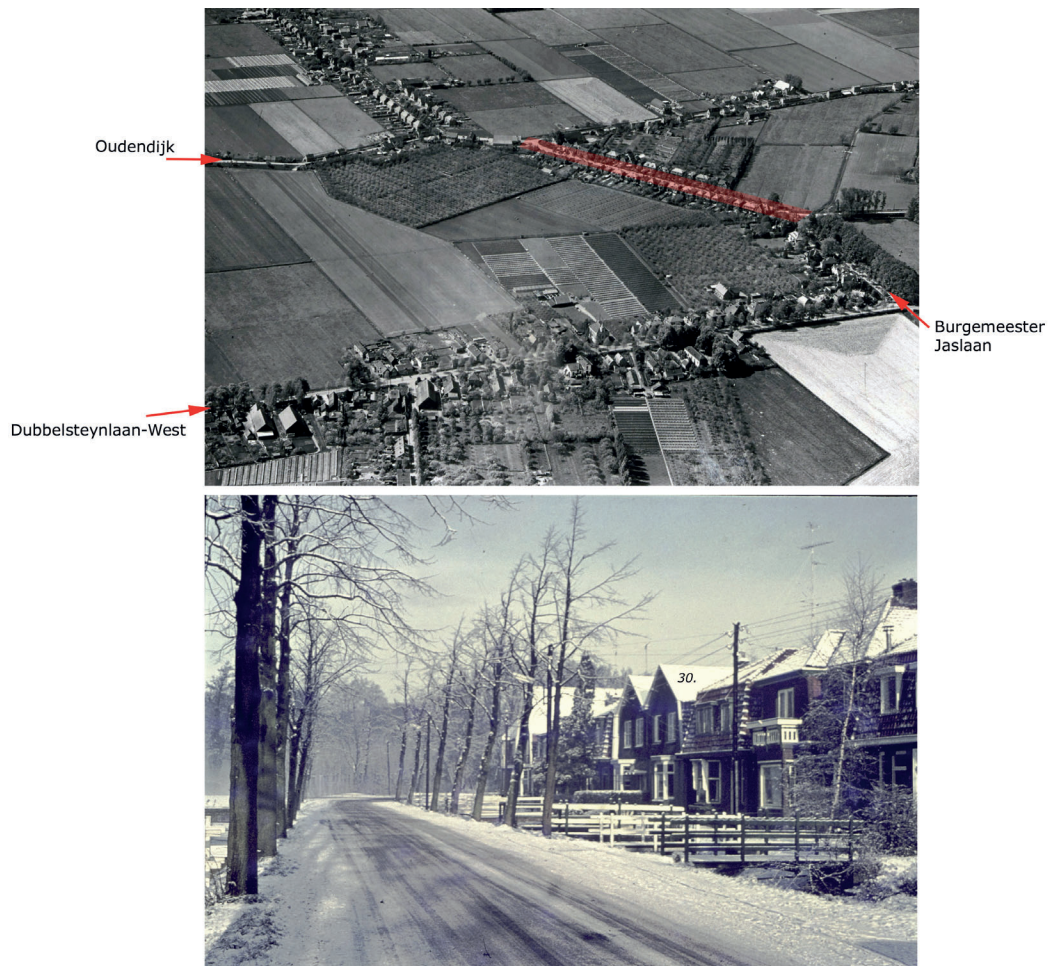
Afb. 11. Boven: het plangebied (rood) in 1952 gezien in vogelvlucht in zuidelijke richting (RAD inventarisnr. 552_313525). Onder: een deel van het plangebied in de periode 1960-1969 gezien in de richting van de Achterweg met in het midden, ter referentie het huis Burgemeester Jaslaan 30. Voor de huizen is nog een sloot aanwezig die bij benadering onder de huidige stoep zal liggen (RAD inventarisnr. 947_1812).
