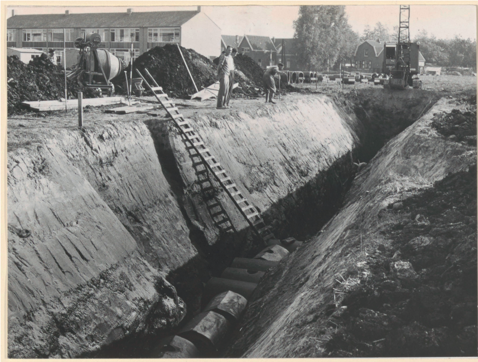
Afb. 17. De aanleg van het riool in de Heijermansstraat, gezien vanaf de Nijhofflaan in de richting van de Damstraat. Op de achtergrond de huizen Damstraat 57/67. De bodemopbouw is hier goed te zien; de bovenste ca. 2 m bestaat uit zand en klei behorende tot het Merwededek met daaronder veen/kleilig veen van het Hollandveen Laagpakket. (RAD inventarisnr. 552_319134).
