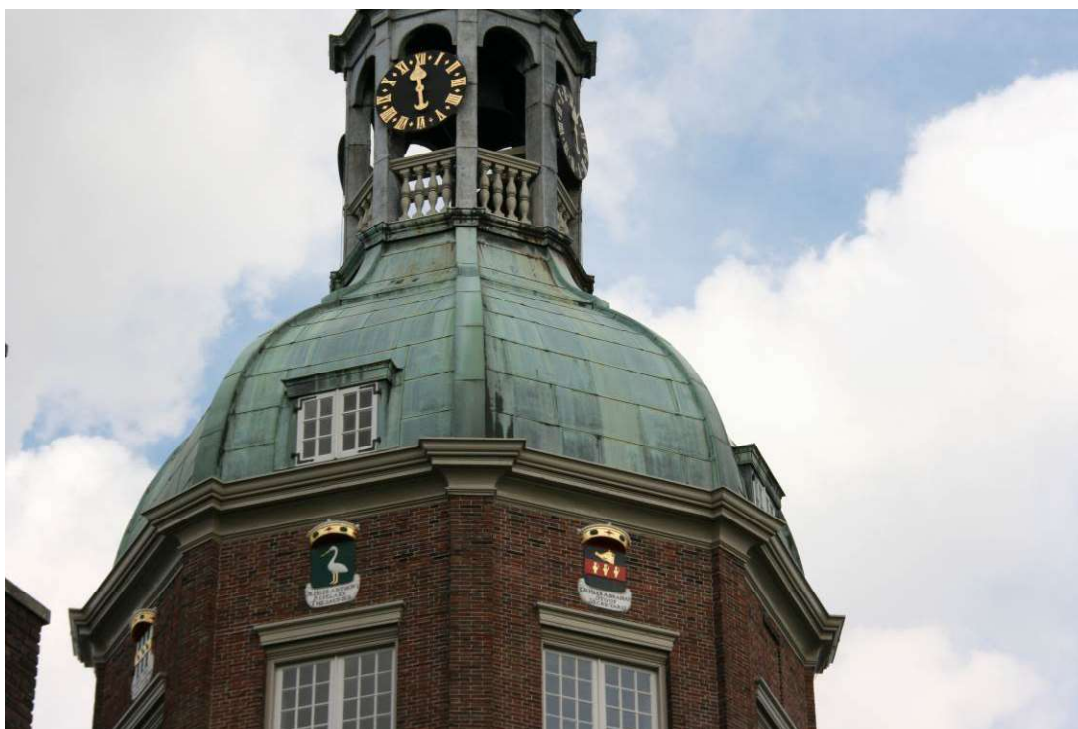
Abbeelding 15: koperen dakbedekking. Groothoofdspoort, Dordrecht.
