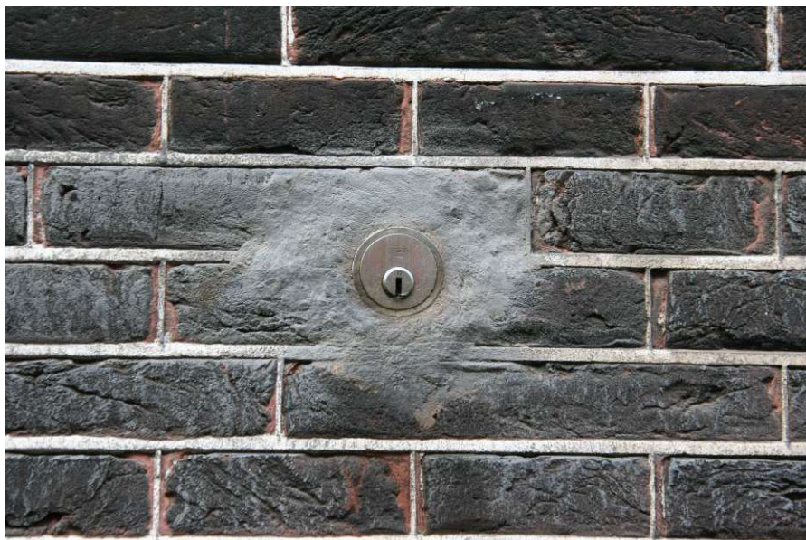
Afbeelding 13: Nieuwe voorzieningen: een ingemetselde brandweersleutel. Niet omkeerbaar. Kan fraaier. Wijnstraat, Dordrecht.
