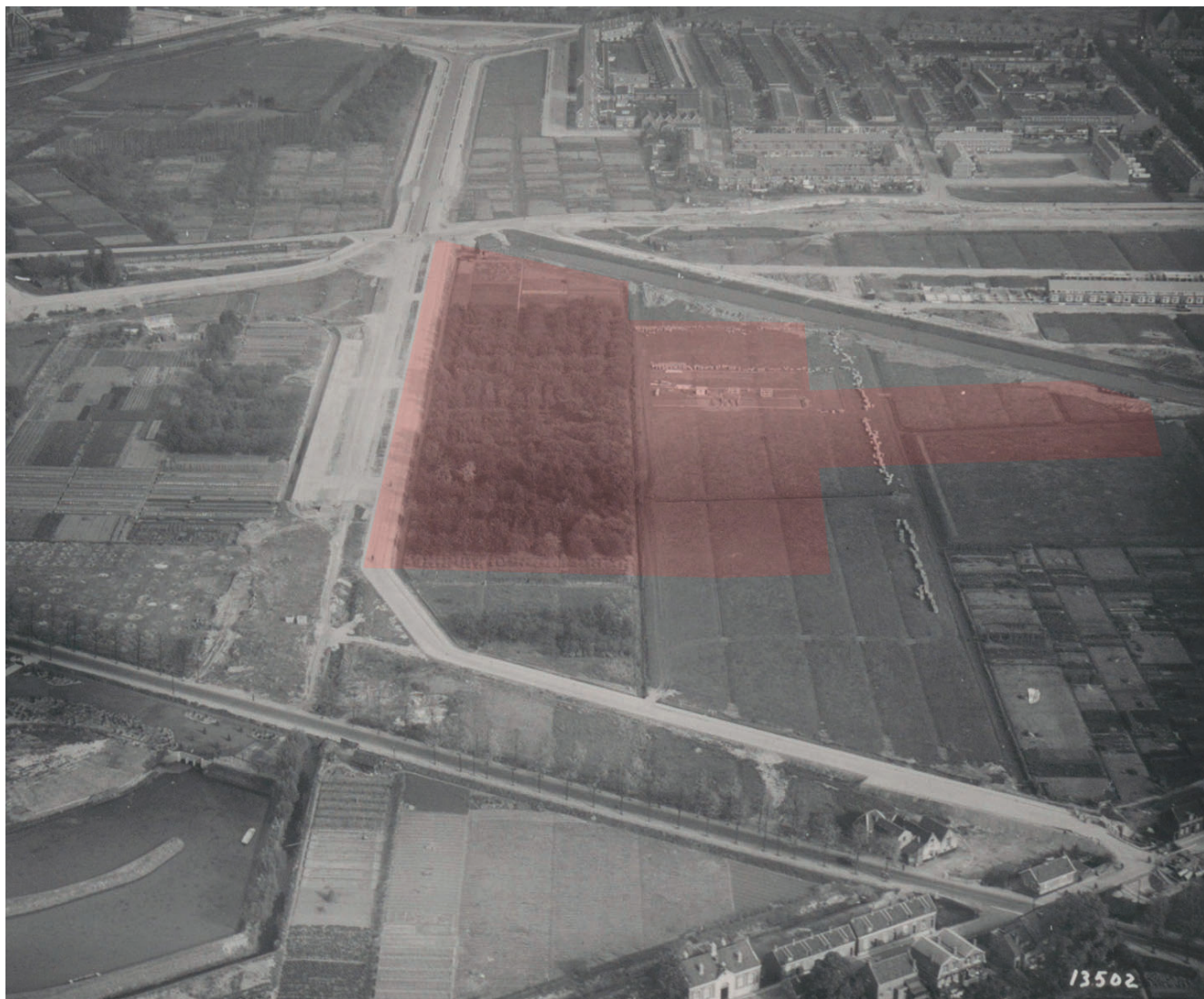
Het plangebied (rood) tijdens de aanleg van de wijk Oud-Krispijn in 1936-1937, gezien naar het noordoosten. (RAD inventarisnr. 552_328129).
