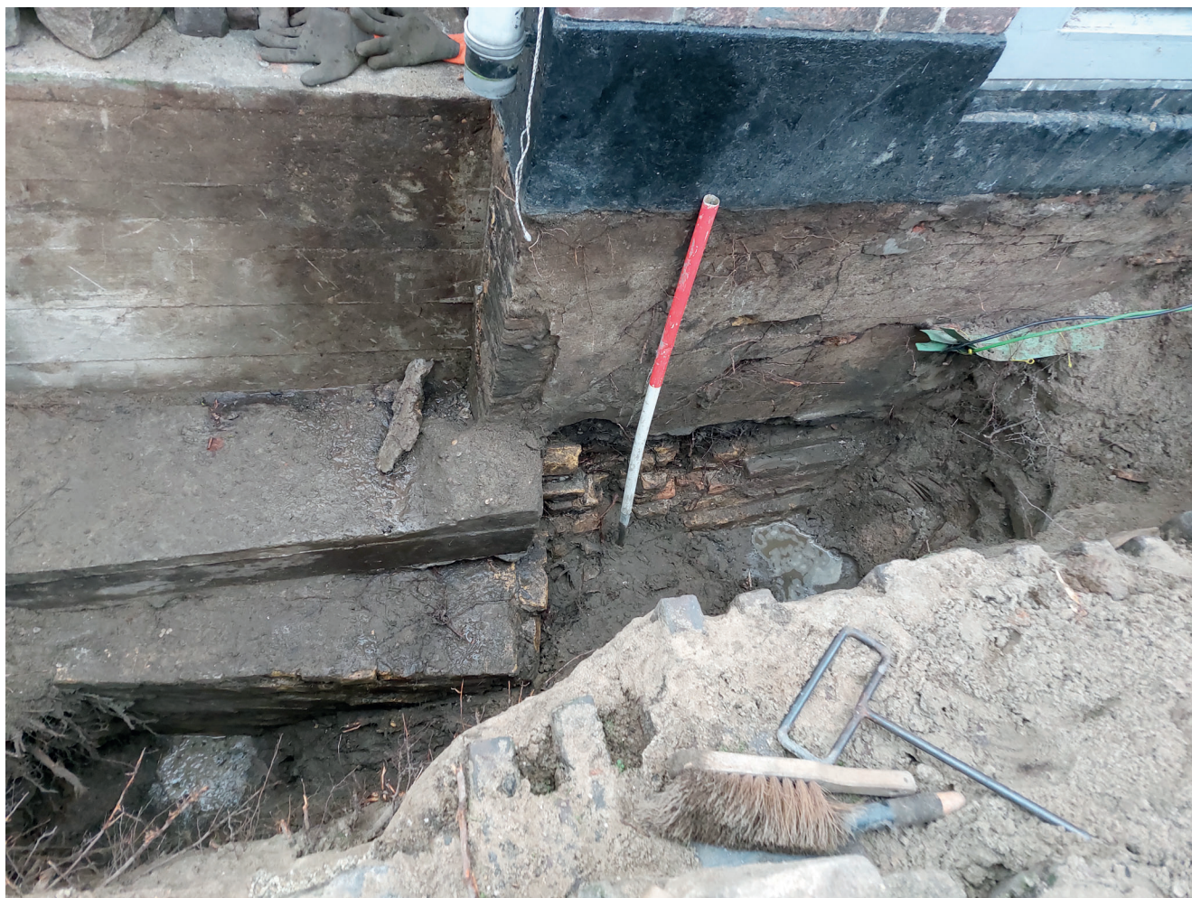
De sleuf voor het funderingsonderzoek aan de Mattensteiger 1 met daarin het aangetroffen muurwerk (foto: Dorst 2021, vakteam erfgoed).
