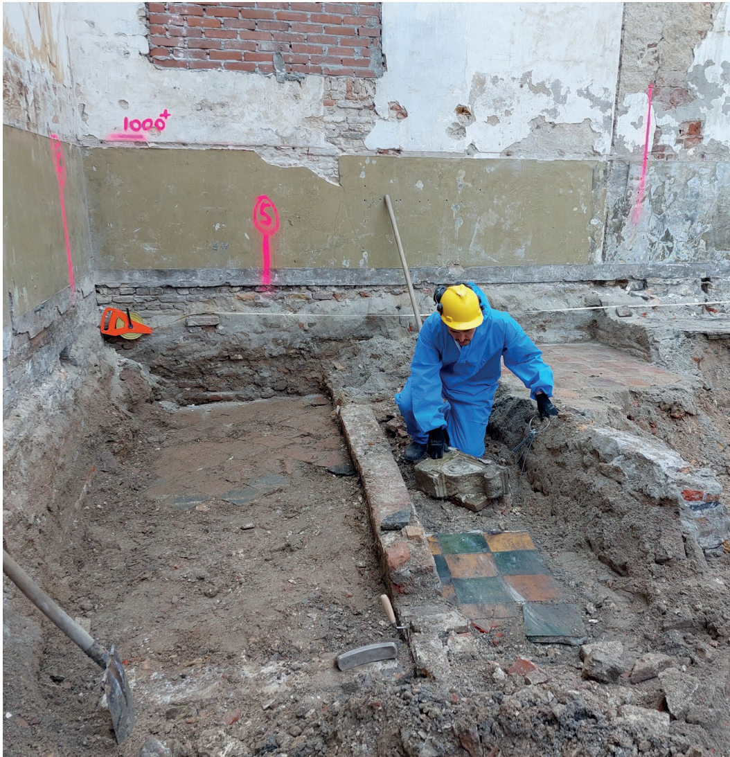
Een sfeerimpressie van de werkzaamheden aan de Augustijnenkamp (foto: vakteam erfgoed, gemeente Dordrecht).
