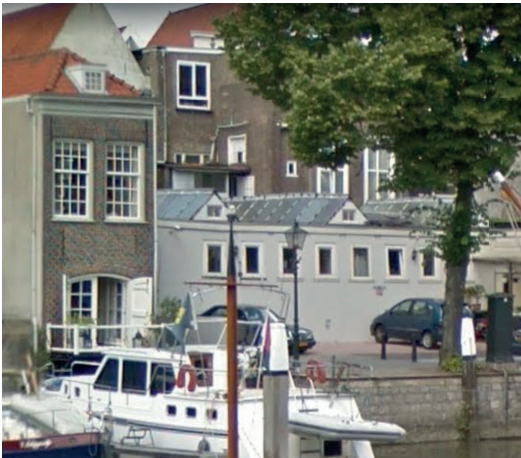
Het onderzoeksgebied gezien vanaf de Taankade; in grijs. gelegen aan de Mattenkade is de 20e -eeuwse bebouwing die gesloopt zal worden, waarna nieuwbouw zal plaatsvinden (foto: Google Maps, 2021).
