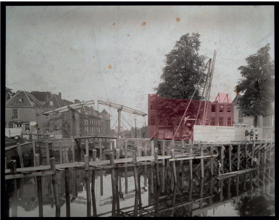
Afb. 16. Een foto van de start van de sloopwerkzaamheden in de periode 1910-1911, gezien vanaf de Houttuinen in de richting van de Oude Maas. Op de voorgrond de nood-/werkbrug in de Nieuwe Haven. Een deel van het dak van het pand Blauwpoort is al gesloopt (rood) (RAD inventarisnr. 554_10079).
