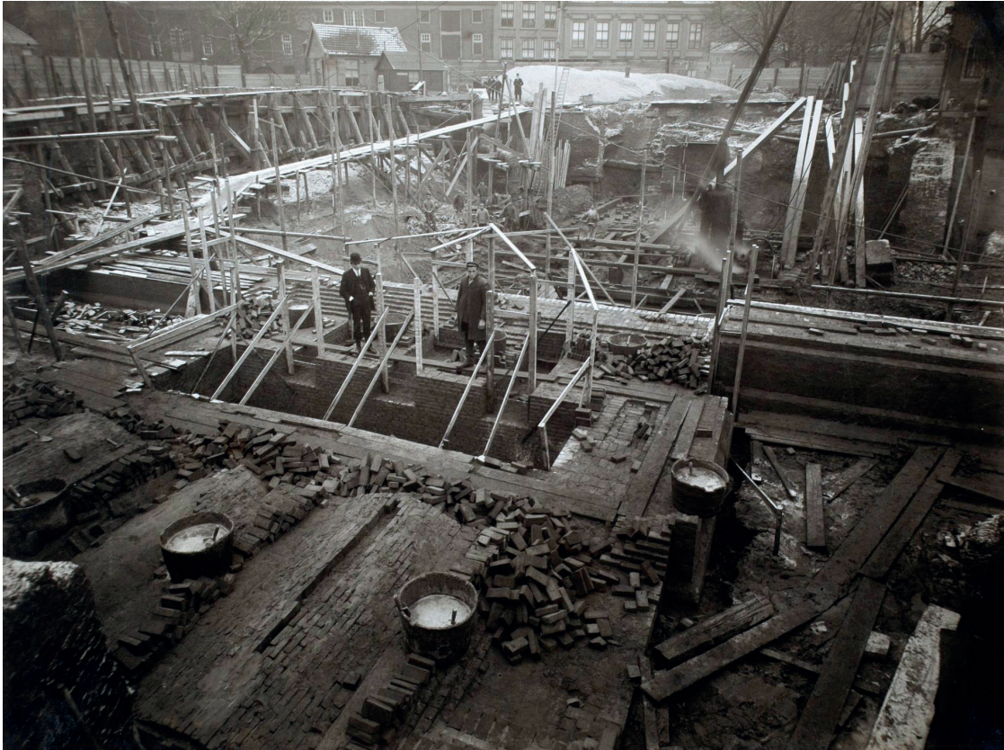
Afb. 18. Een foto van de bouw van de basculekelder van de huidige Engelenburgerbrug vanaf het noordelijke brughoofd (Nieuwe Werk) in de richting van de Grote Kerk/Houttuinen. Voor de twee staande mannen is de kelder te zien waarin het brugdeel wegzakt wanneer de brug omhoog gaat (RAD inventarisnr. 554_20018).
