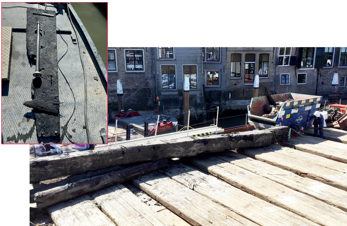
Afb. 25. Aan boord van het werkschip is één van de drie grote funderingsbalken van het brughoofd uit 1410. In de inzet is één van de planken met ijzeren spijkers te zien (foto's: dhr. De Vet, bewerkt door: Dorst 2021, vakteam erfgoed).
