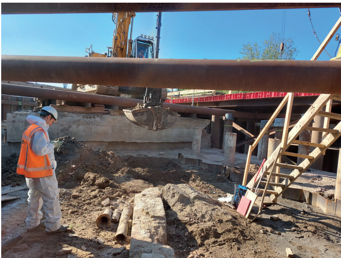
Impressie van het veldwerk op 16 juni 2021 tijdens het graafwerk op het Blauwpoortsplein met in het midden de funderingsresten van de 17e-eeuwse Blauwpoort, gezien in zuidoostelijke richting (foto: M.C. Dorst, vakteam erfgoed).
