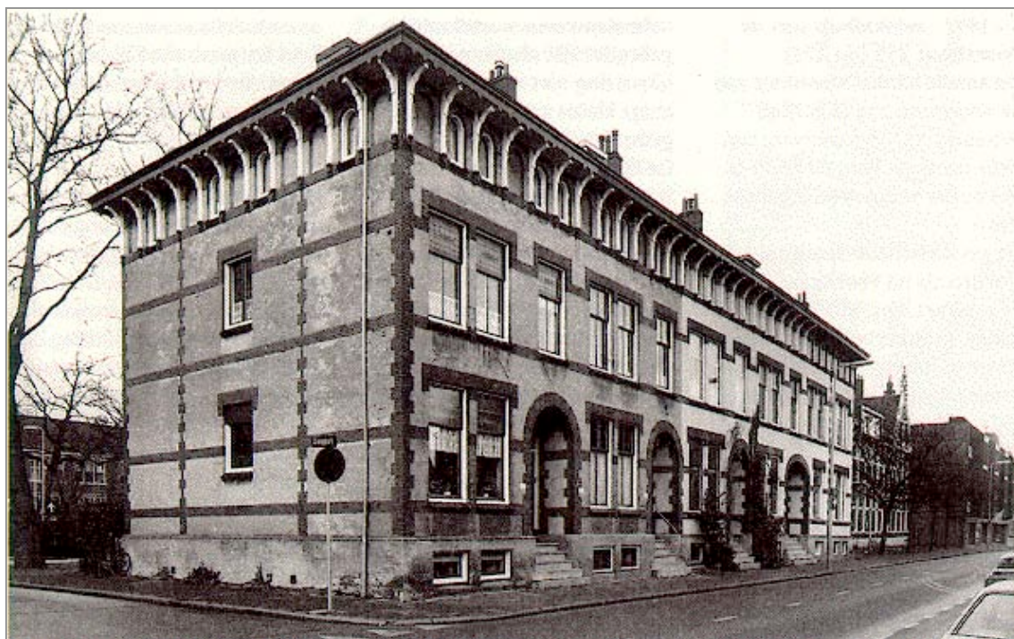
Woningblok van Reus, gezien vanuit het zuiden, foto uit 1989. (Foto Rijksdienst voor het Cultureel Erfgoed)
