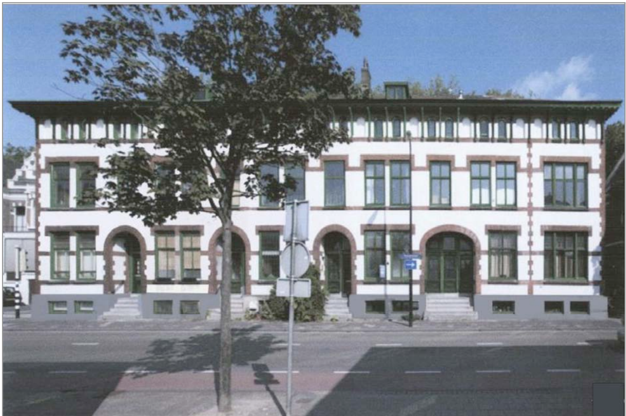
Onder: Oorspronkelijke situatie, kleur en materialisering als bindende factoren (foto Huib Kooyker/bewerking David Groeneweg)
