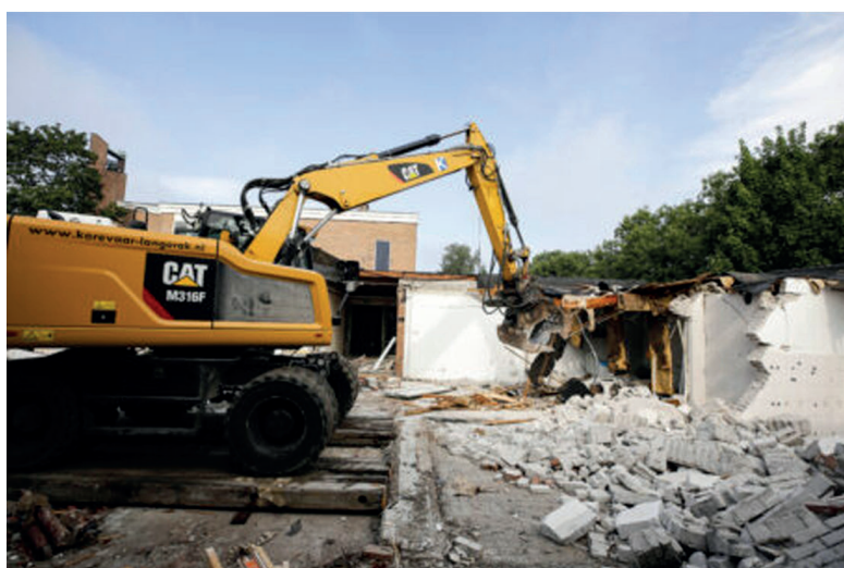
Afb. 4. De werkzaamhedentijdens de sloop van De Rank (foto's: Thyemen Stolk, Dordt Centraal). 2
