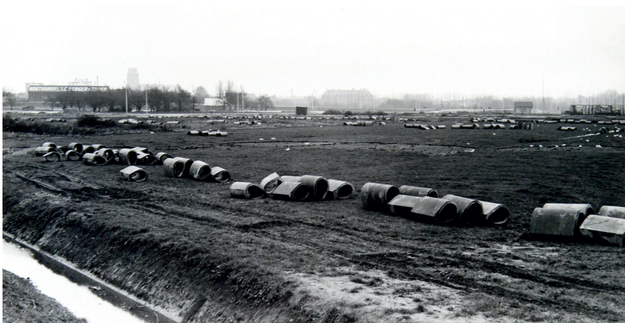
De aanleg van het nu verwijderde riool in de wijk Krispijn in 1937 (RAD inventarisnr. 555_14832).
