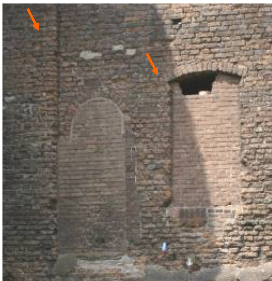
Afb 85. Binnenzijde westgevel. De pijlen geven de rijen klezoren aan.
