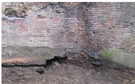
Afb. 41 De binnenzijde van de westmuur van de ruïne.
