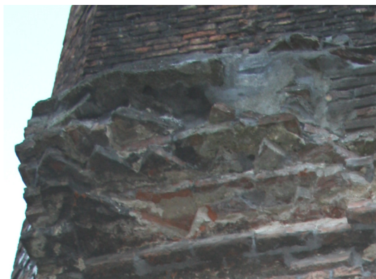
Afb. 19 Door het aanbrengen van kruislagen hoopte men waarschijnlijk meer samenhang te creëren in het inwendige van de muur. Misschien speelde ook mee dat men zoveel mogelijk trachtte te voorkomen dat er voegen boven elkaar kwamen te liggen. Bij dit afgebrokkeld muurwerk aan de zuidzijde van de ruïne zijn de kruislagen goed zichtbaar geworden.
