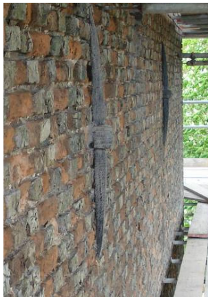
Afb. 42 Ankers in de westgevel van de balkenlaag van de eerste verdieping.
