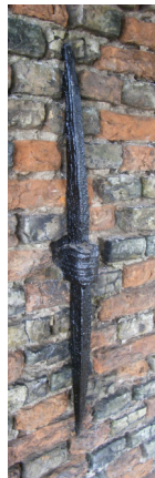
Afb. 42 Ankers in de westgevel van de balkenlaag van de eerste verdieping.
