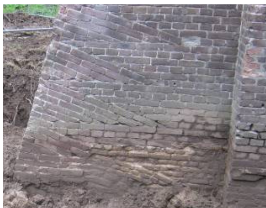
Afb. 40 Funderingsherstel uit diverse fasen: vlechtwerk en een herstelling van vlechtwerk.
