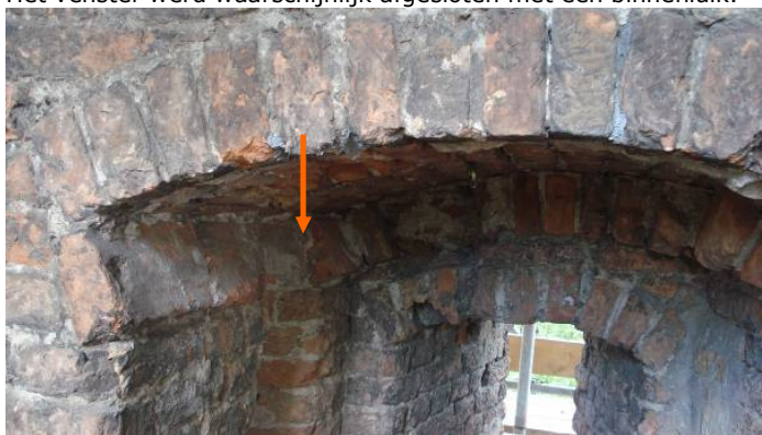
Afb. 50 Zicht op de afgeschuinde wangen. Links een extra hoek tussen de dagkant en sponning (pijl). Boven de segmentboog van de smalle lichtopening is een varken te zien.
