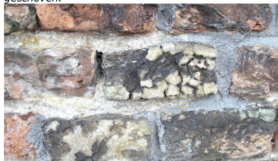
Afb.23 Misbaksels van verglaasde stenen zijn overal verwerkt in het metselwerk, zowel aan de binnenzijde van de toren als in het massieve muurwerk.
