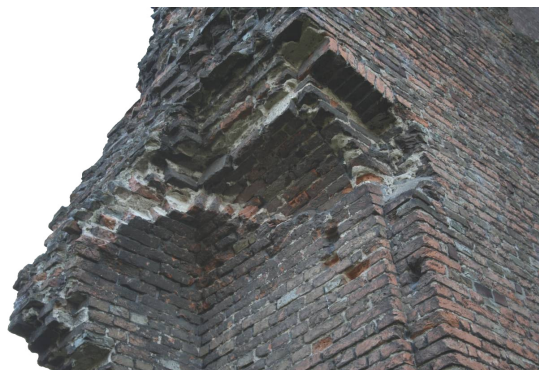
◀ Afb.86 De muuropening aan de zuidzijde van de toren, met klimmend gewelf en een smalle dagkant van een venster of andere opening.
