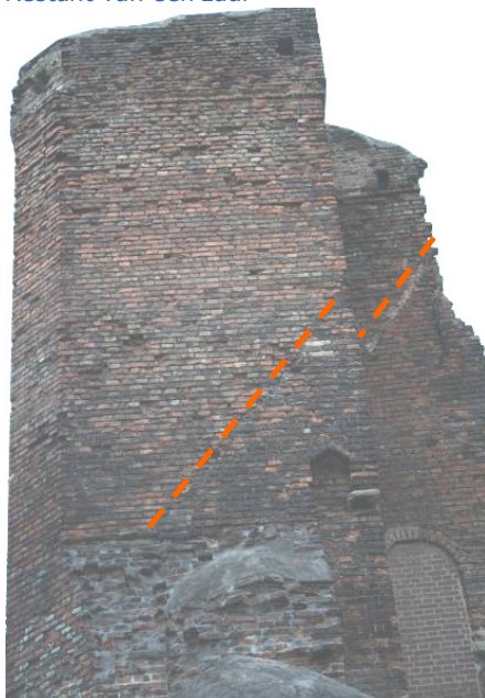
◀ Afb.80 Sporen van de dakmoet in de zuidkant van de traptoren
