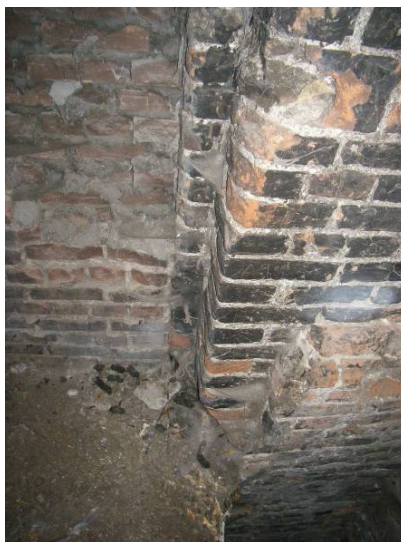
▲ Afb. 47 Foto genomen door de spleet (blauwe kader afb. 44) in de westgevel op de verdieping. Rechts lijken sporen in het metselwerk waar mogelijk de plank heeft gezeten.
