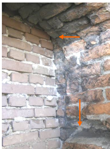
◀ Afb. 52 Westgevel, het venster op de verdieping waarin aan beide dagkanten sporen zijn van vermoedelijk een glassponning, een kalf en horizontaal traliwerk.
