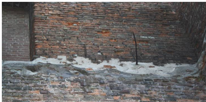
Afb. 42 Ankers in de westgevel van de balkenlaag van de eerste verdieping.
