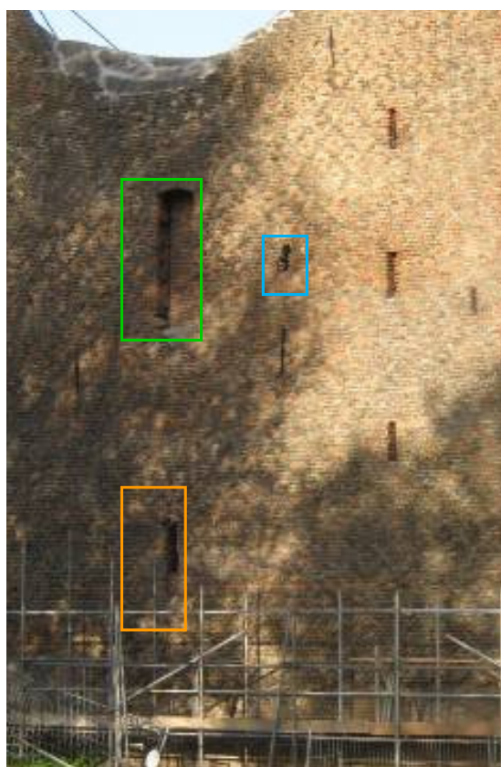
Afb.45 Westgevel met muuropeningen.
