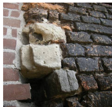
Afb. 74 natuurstenen blok in zuidgevel
