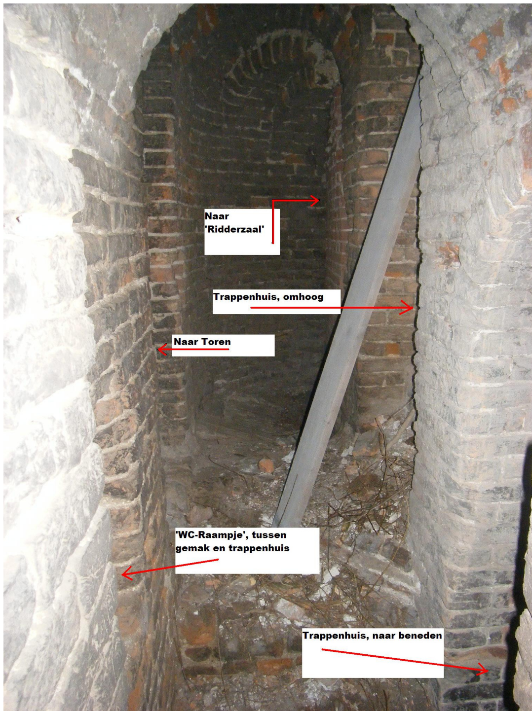
Afb. 93 Deze foto is genomen vanuit het lichtgat in de westgevel op de verdieping in de toren. Hierdoor is zicht op de trap en enkele doorgangen. Foto bewerkt door J. Nipius.
