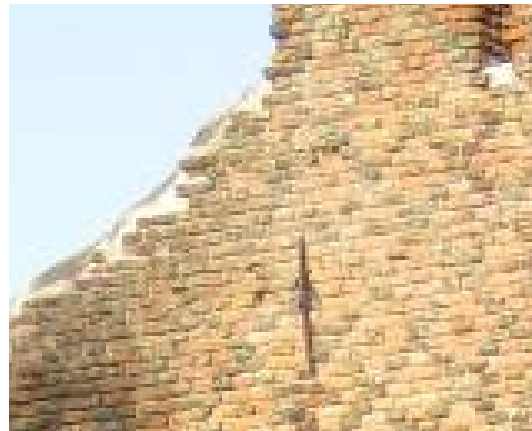
Afb. 43 Anker in de westgevel op het niveau van de tweede verdieping.
