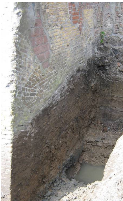
Afb. 39 Restauratiewerk aan de funderingen in 2010. Daarboven zijn vele herstellingen te zien uit de negentiende en twintigste eeuw.
