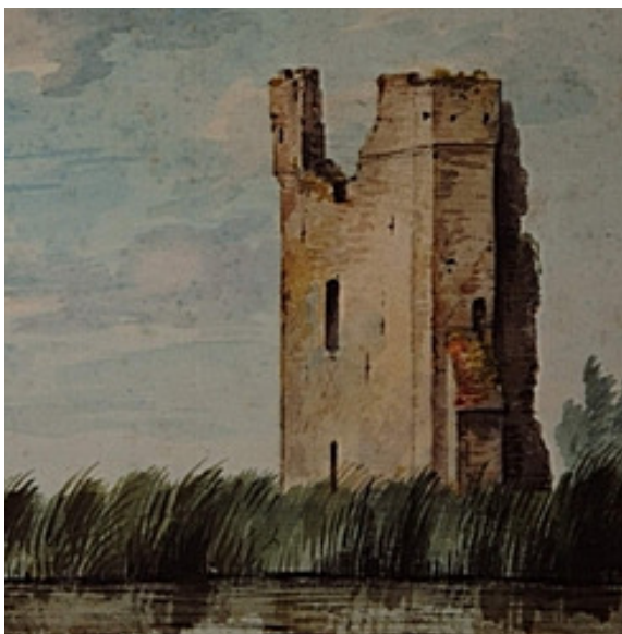
6 Arend Schouman 1745. In de westgevel (de gave gevel) is bovenin nog het venster net onder de weergang zichtbaar. Aan de zijkant van de toren is net boven het nisje een dakmoet te zien van het dak van een zaal.
