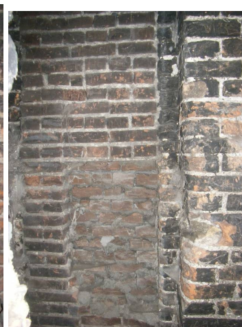
Afb. 92 Dichtzetting naar het gemak.
