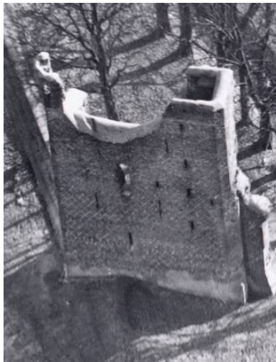
Afb. 88 Luchtfoto uit 1939, zicht op de traptoren.
