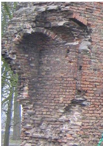
◀ Afb.86 De muuropening aan de zuidzijde van de toren, met klimmend gewelf en een smalle dagkant van een venster of andere opening.
