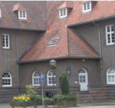
Dakvlakken en overstek
