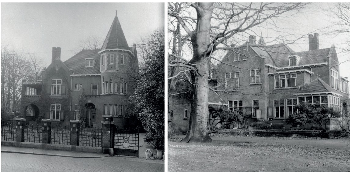
Afb. 32. Een foto uit 1960 van de villa Lotsy. Links: de voorzijde gezien vanaf de Wijnstraat in westelijke richting. Rechts: de achterzijde vanuit de tuin. De eerder genoemd containerlocatie (pagina 21) ligt naar verwachting net achter de achtergevel, ter hoogte van het verhoogde terras (RAD inventarisnr. 554_34388 en 554_34383).
