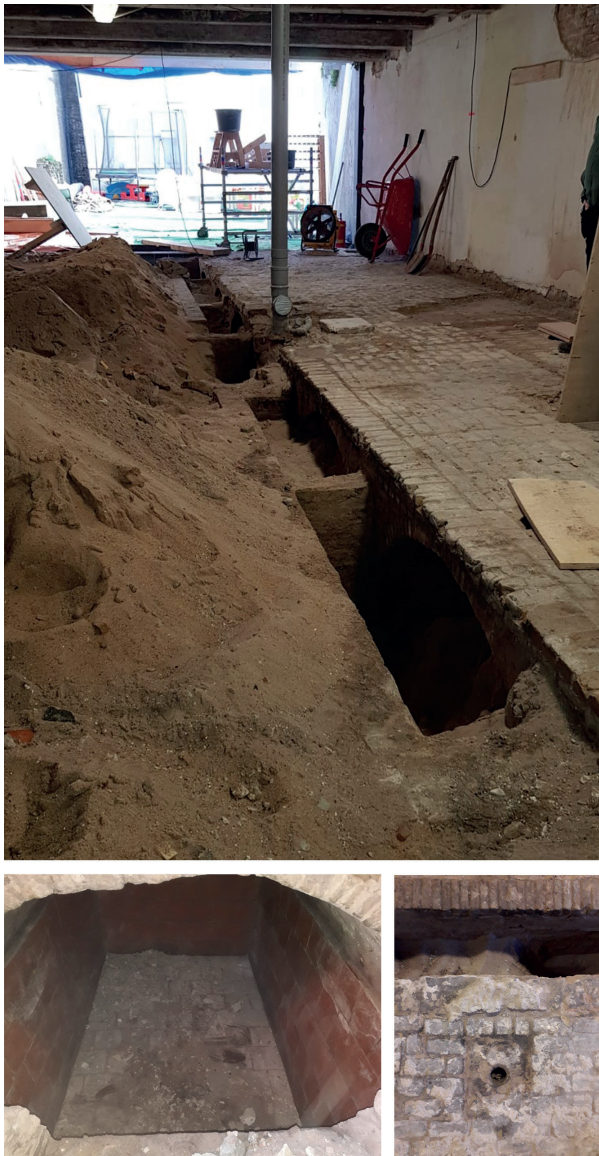
Afb. 13. Boven: het vloeistofreservoir S3 met daarop de vloer S1 gezien richting de (weggebroken) achtergevel en tuin. Onder, links: het westelijkste compartiment met tegels en plavuizen. Onder, rechts: één van de natuurstenen blokken met gat in de vloer S1 waardoor vloeistof in of uit de reservoirs gedaan kon worden, gezien van bovenaf. Hier is ook de smalle, open goot te zien die toegang gaf tot de compartimenten.
