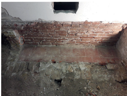
Afb. 15. Boven: de tegelwand van de oostelijk keldermuur van het centrale deel van de kelder. Onder, links: het oostelijke lagere, gewelfde compartiment, gezien vanuit het centrale deel van de kelder. Onder, rechts: het middelste lagere, gewelfde compartiment gezien in de richting van het centrale deel van de kelder. Beide compartimenten hebben een ongeglazuurde plavuizenvloer en een plint van groen-geel gekleurde plavuizen. Onder: De vermoedelijk entree tot de kelder (S9 en S11) met ongeglazuurde plavuizenvloer (S10), gezien in noordoostelijke richting. De rode cirkel is de locatie waar ook restanten van Delfts-blauwe wandtegels aanwezig waren.
