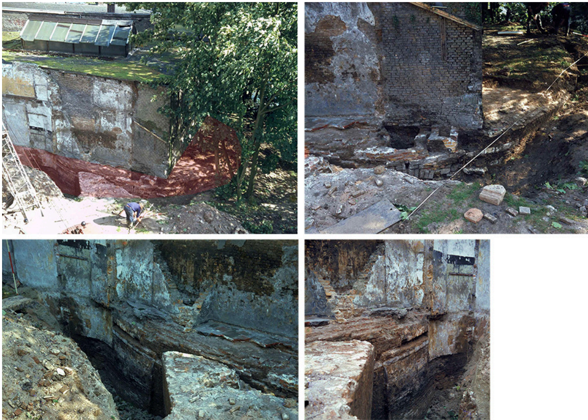
Afb. 8. Enkele foto's van de vrijgegraven fundering (met vloerrestant) van de Lotkenstoren met daarop het pand van de garage Blom. Linksboven: de torenfundering gezien in oostelijke richting, door de bomen is het water van de Spuihaven te zien. Op de foto's is te zien dat het om een ronde toren gaat met aan de linkerzijde de versmalde muur/gangaansluiting naar de stadsmuur. Op de onderste twee foto's is ook de nieuwe stadsmuur uit circa 1630 te zien, waarmee de St. Adriaansbuurt binnen de stad kwam te liggen (RAD inventarisnummers vanaf linksboven met de klok mee: 951_1972, 951_1974, 951_1977 en 951_1976).
