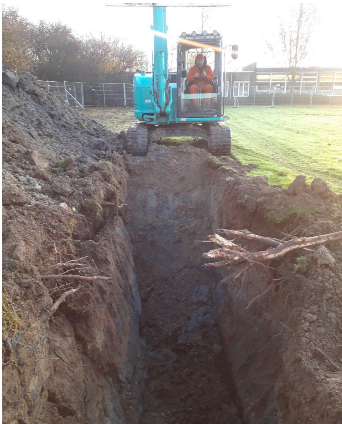
Een sfeerfoto van de aanleg van de put ter hoogte van de boring waarin in het vooronderzoek archeologische indicatoren zijn aangetroffen (Foto: vakteam erfgoed, 2019, M.C. Dorst).
