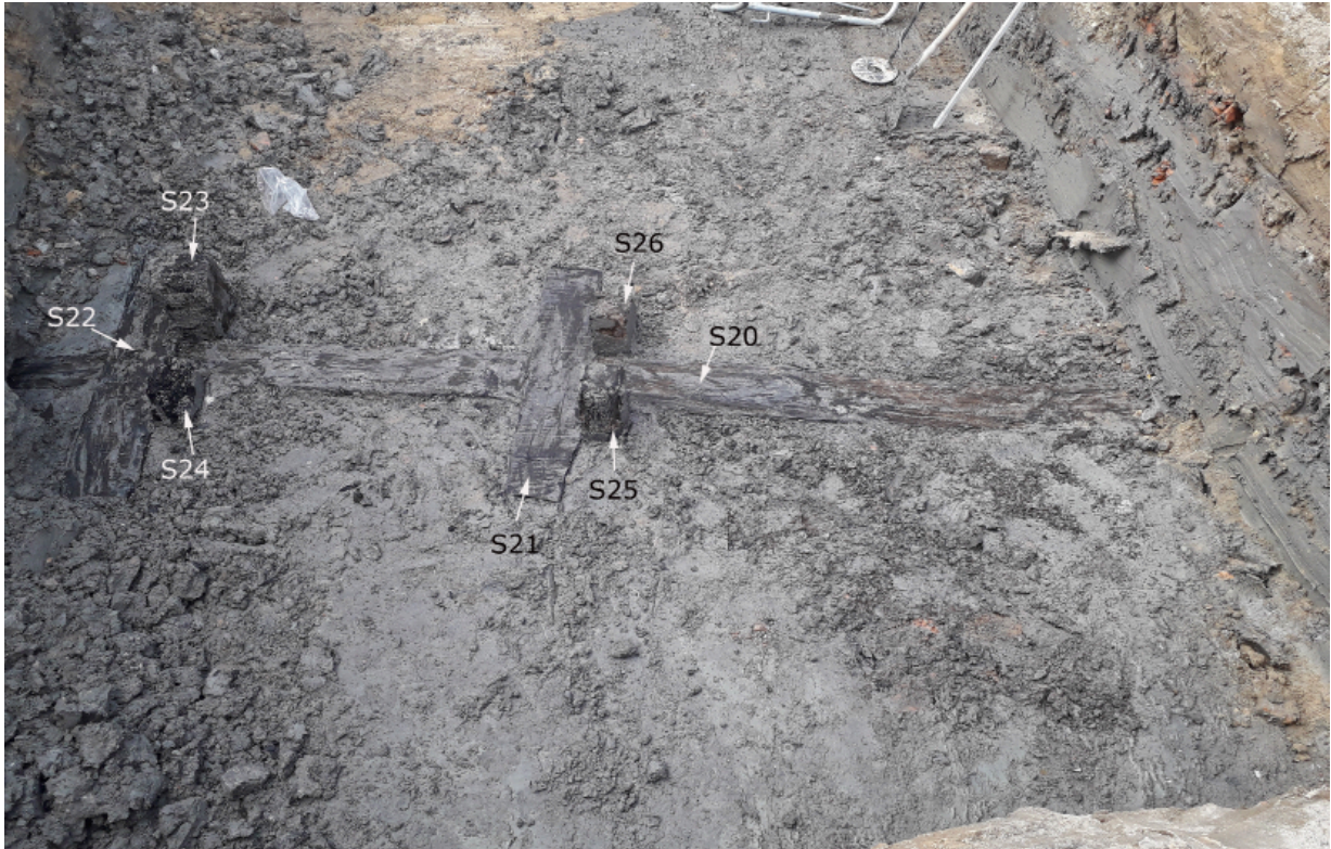
Afb. 14. Het trek-anker van de 17e-eeuwse kademuur van het Maartensgat in put 11, gezien in zuidwestelijke richting. Het vlakniveau is de onderzijde van de put van de boombunker op circa 1,9-1,95 m – mv (ca. 1,1 m + NAP).
