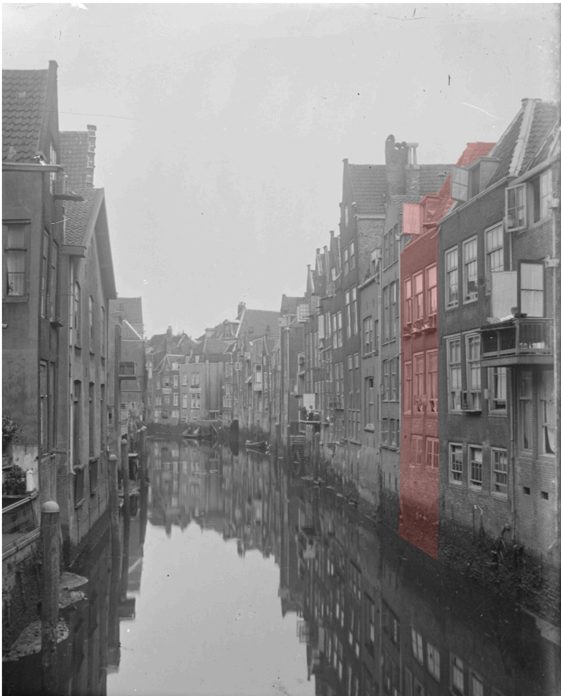
De achter- /watergevel van het plan- en onderzoeksgebied Voorstraat 417 in de periode 1950-1959 gezien vanaf de Pelsbrug richting Lombardbrug (rood) (RAD 552_701116). Het onderzochte souterrain/ kelder ligt achter de dubbele ramen.
