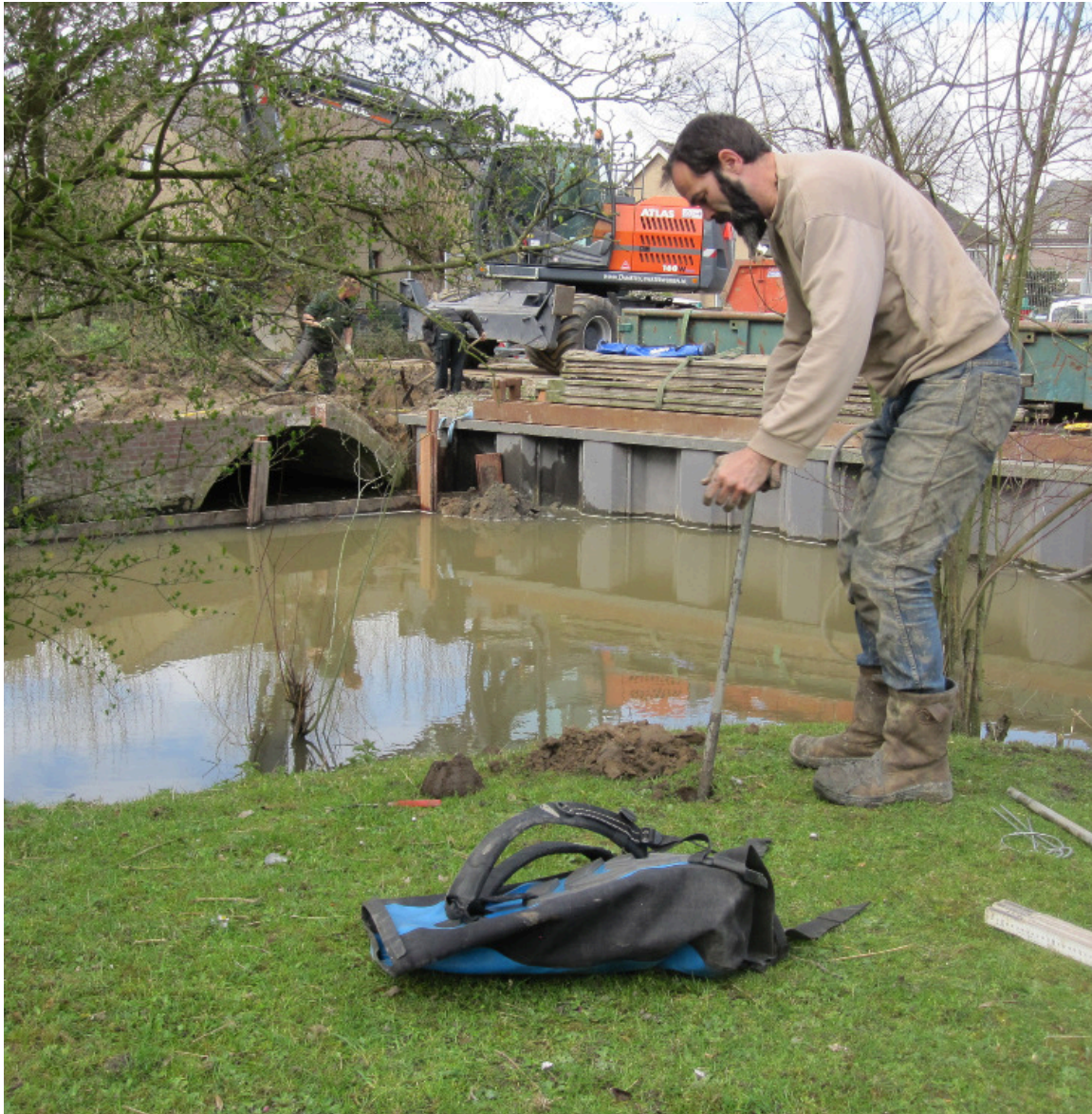
Sfeerfoto van het veldwerk op 27 maart 2019 met op de achtergrond de werkzaamheden aan de brug/duiker in de Dubbeldamseweg-Zuid (foto: Cees van der Esch, AWN Lek- en Merwestreek, 2019).
