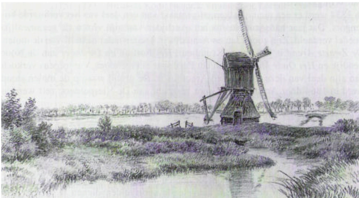
Afb. 9. De wipwatermolen uit 1616 die het overtollige water in de Dubbeldamse polder van de Raamkil/Molenvliet op het buitenwater/de Merwede loosde (F. Lebret, 1845). 16
