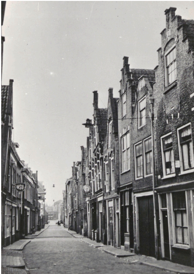
Afb. 7. De Kolfstraat tussen 1953 en 1957, vóór de grootschalige sloop van de huizen gezien in de richting van de Vest (achtergrond). De voormalige Dwarsgang (huidige verlengde Sarisgang) is herkenbaar als een streep licht achter de uitgangsborden. Van de huizen in het plangebied zijn alleen enkele voorgevels te zien. Het pand linksachter met de hoge nokken is de nu nog aanwezige Museumstraatschool (de huidige Dr. H. Bavinckschool). Hiernaast, mogelijk deels in het plangebied, lijken er al enkele huizen te zijn gesloopt (RAD, inventarisnr. 552_322508).
