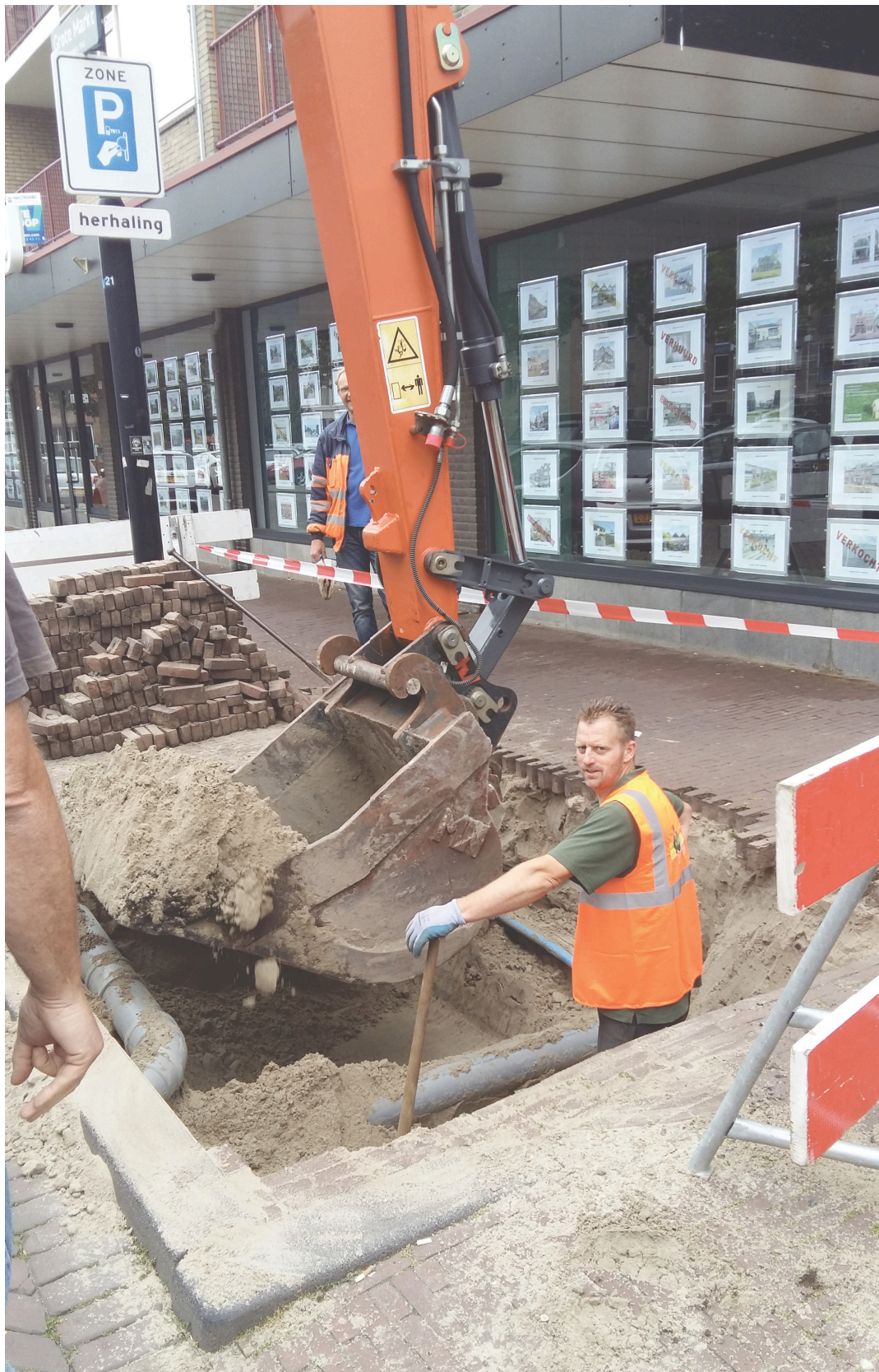
Het graven van de put voor de ondergrondse kledingcontainer op de locatie 's Heer Boeijenstraat 89.
