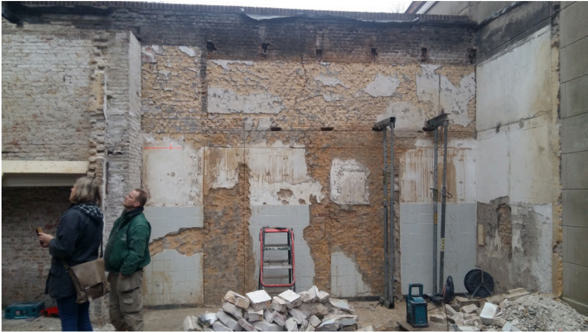
De tussenmuur in het onderzoeksgebied vóór aanvang van de graafwerkzaamheden.
