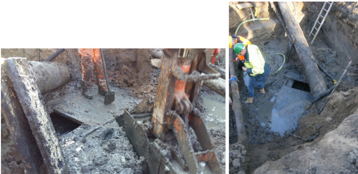
Afb. 8. Enkele foto's van de 19e-eeuwse, houten duiker.
