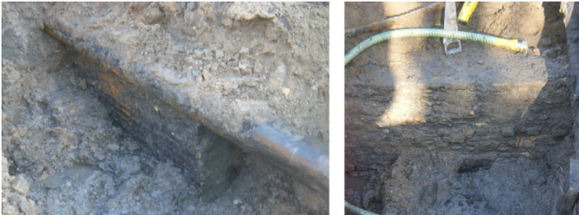
Afb. 7. Links: de vermoedelijke westelijke zijkant van de brug (S2), gezien in noordoostelijke richting. Rechts: de fundering van de brug (S1), gezien in noordelijke richting.
