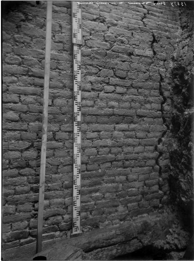
Afb. 5. Een foto van de fundering van de OLV-kerk tijdens een renovatie tussen 1910 en 1921, mogelijk de toren. Hierop is onder de funderingsmuur een zware houten balk te zien. Naast de baak is een gutsboring te zien met daarin een pakket grijze klei/zand (?) met onderin een bruine afzetting, vermoedelijke kleilig veen of weinig klei (foto: Dienst Bouwen en Wonen, RAD inventarisnr. 556_1375).
