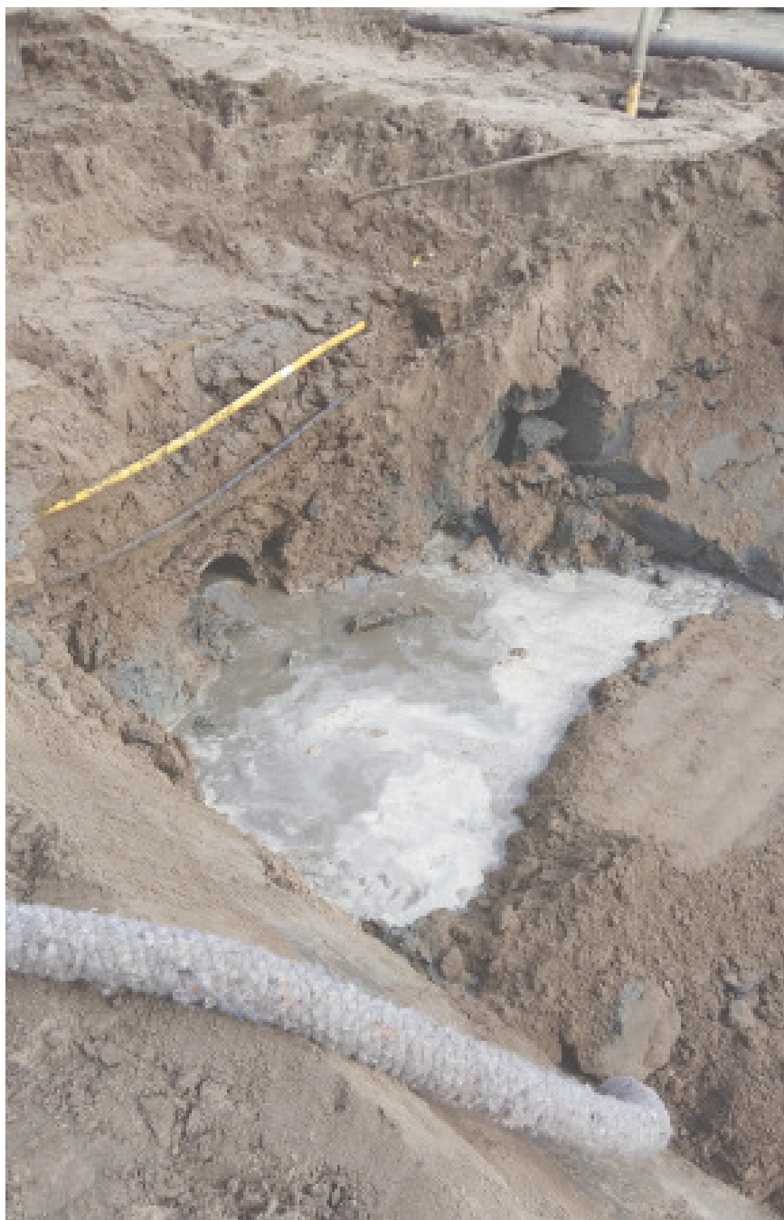
De logistieke problematiek bij het verwijderen van het oude riool in de Spiegelstraat.
