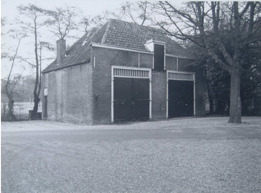
Afb. 8. Het koetshuis (onderzoeksgebied) gezien vanaf de schuur in noordwestelijke richting. De nieuwbouw zal aan de, hier niet zichtbare, achterzijde plaatsvinden. Op deze foto is nog wel de schoorsteen van de haard nog aanwezig (RAD inventarisnr. 552_304639).
