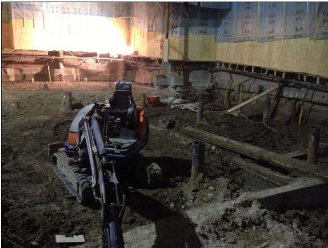
Overzicht van de graafwerkzaamheden in de grote zaal van de schouwburg Kunstmin (2013)
