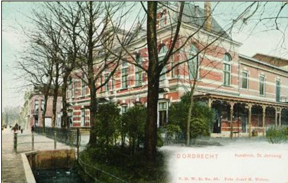
Afb. 5. De tweede bouwfase van schouwburg Kunstmin op een prentbriefkaart uit 1911, gezien vanaf de Sint Jorisweg in noordelijke richting. Op de voorgrond is nog een deel van een wegsloot te zien dat deel uitmaakte van de originele 17 e – eeuwse perceelsindeling. (DiEP inventarisnummer 52_401715).
