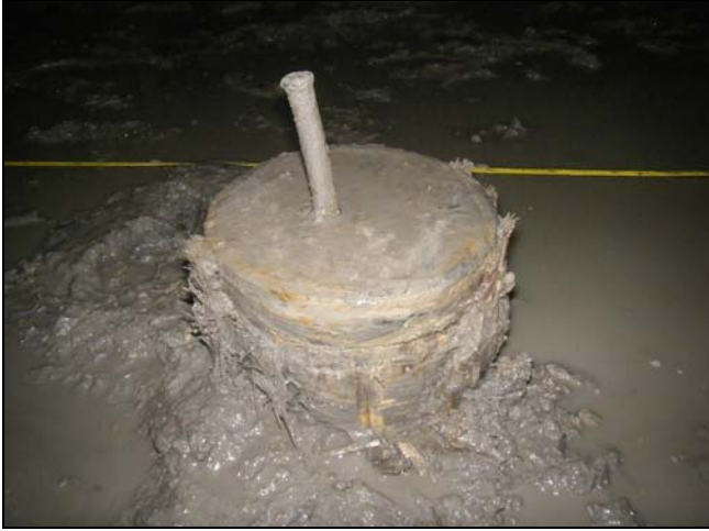
Afb. 6. Eén van de 19-eeuwse houten funderingspalen van schouwburg Kunstmin.
