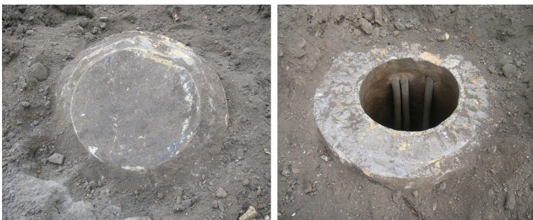
Afb. 22. Links: de destijds zichtbare putafsluiting met bakstenen in een decoratief keperverband. Rechts: de binnenzijde van de waterput met de drie loden aanvoerleidingen, gezien in de richting van het huis aan de Binnen Walevest.
