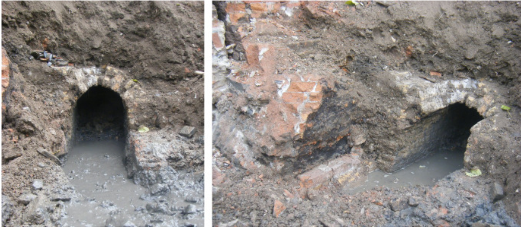
Afb. 19. Links: het riool S4 gezien vanuit de rivier in de richting van het huis aan de Binnen Walevest. Rechts: het riool met restanten van de nieuwe doorgang in de kademuur van (vermoedelijk) 1850; de restanten van de overkluizing met fabriekssteen en de zwarte verkleuring geven de nieuwe uitlaat aan.
