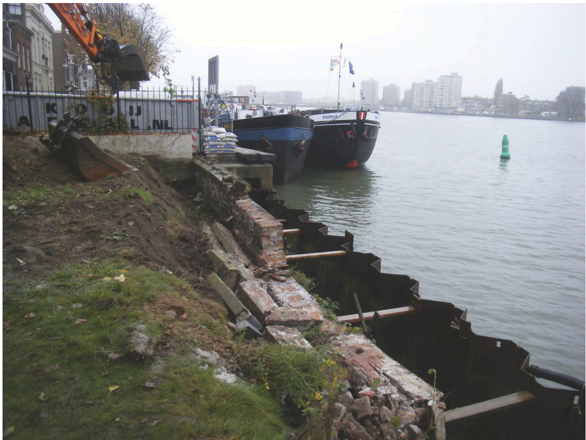
De start van de werkzaamheden aan de Binnen Walevest; de sloop van de bovenbouw van de kade. In het water van de Oude Maas is de damwand te zien die een droge kuip langs de kade vormde (Foto: Vakteam Erfgoed).
