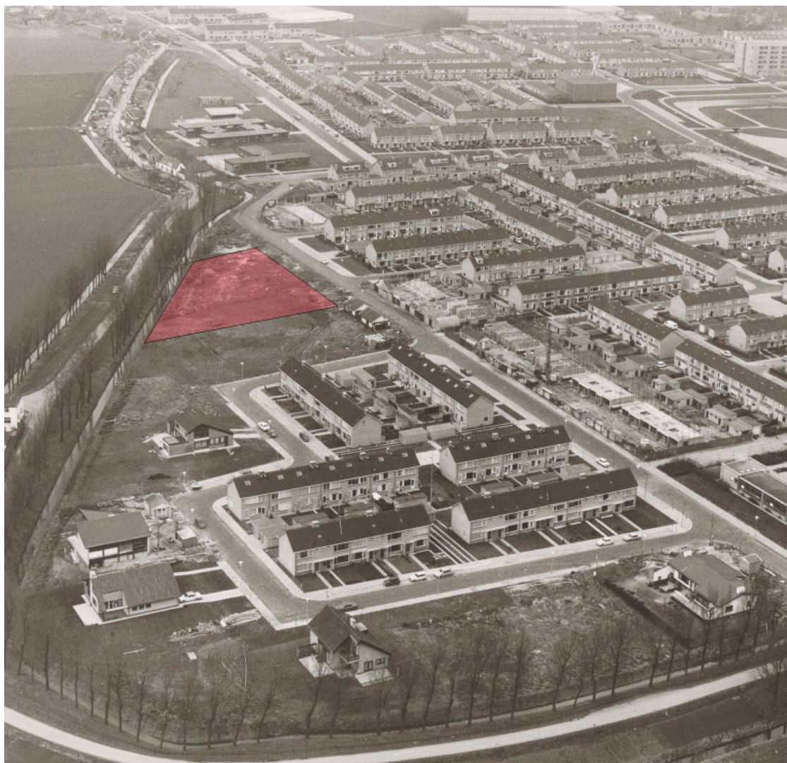
Het plangebied op een luchtfoto uit 1971 gezien in noordwestelijke richting (RAD inventarisnr. 552_322704).
