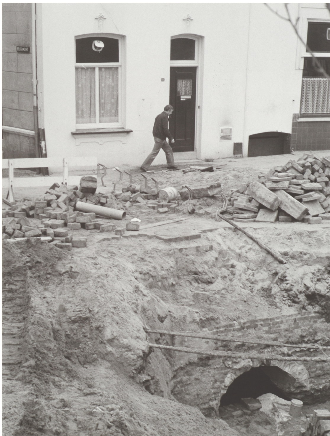
Een foto van de bakstenen overkluizing van de Belgracht met de voormalige binnengracht/Lindengracht, aangetroffen tijdens werkzaamheden in 1981 (RAD inventarisnr. 551_35239).
