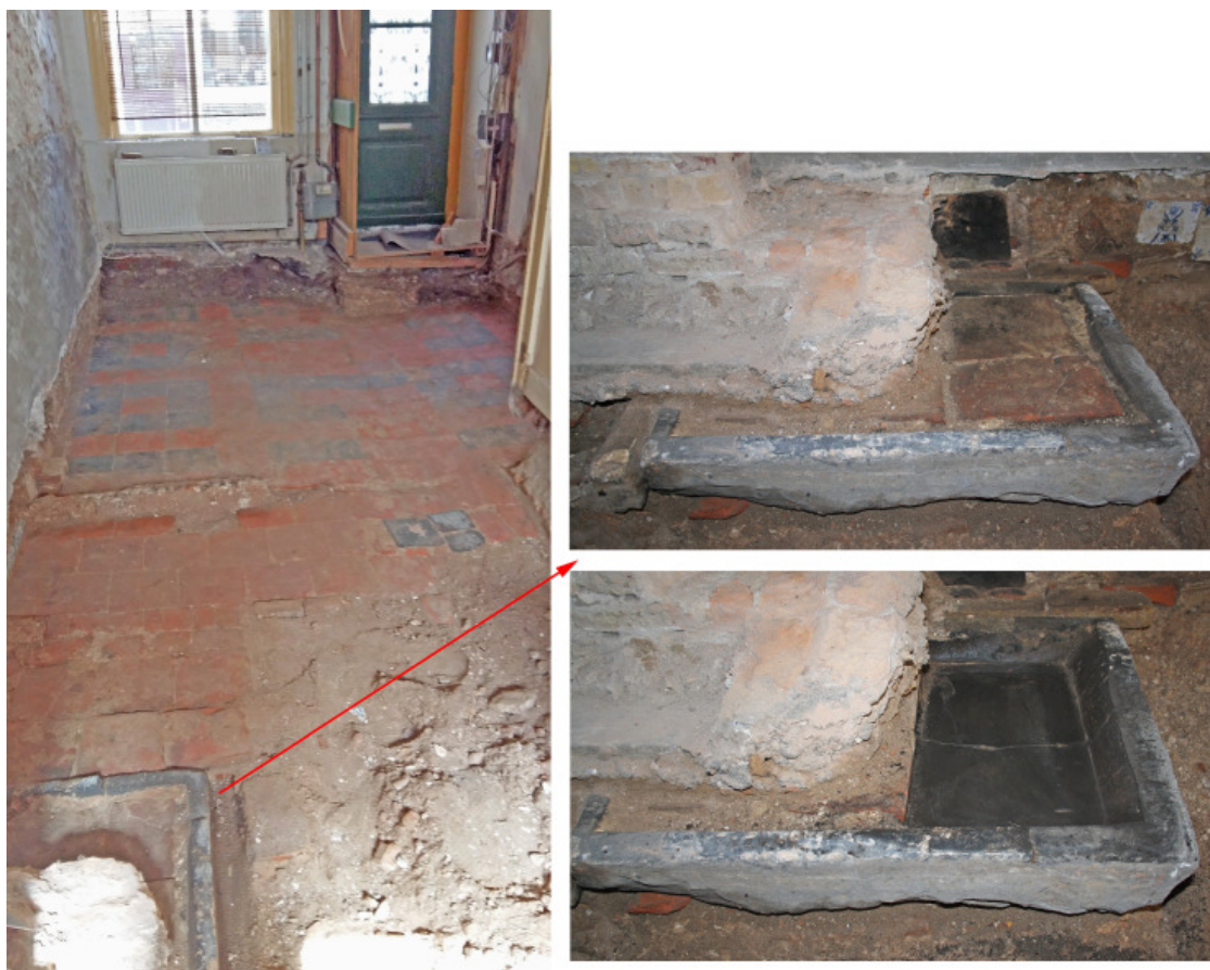
Afb. 22. Links: Een gelijkvloerse verbinding tussen het voor- en achterhuis, waardoor de oudere (stook) bak uit het zicht verdwijnt. Onderin is de tweede bak (S8) die in de vloer is opgenomen te zien. Rechts: de als as-/stookbak hergebruikte gootsteen S8; boven met een vloertje van rode plavuizen en onder zonder plavuizen.
