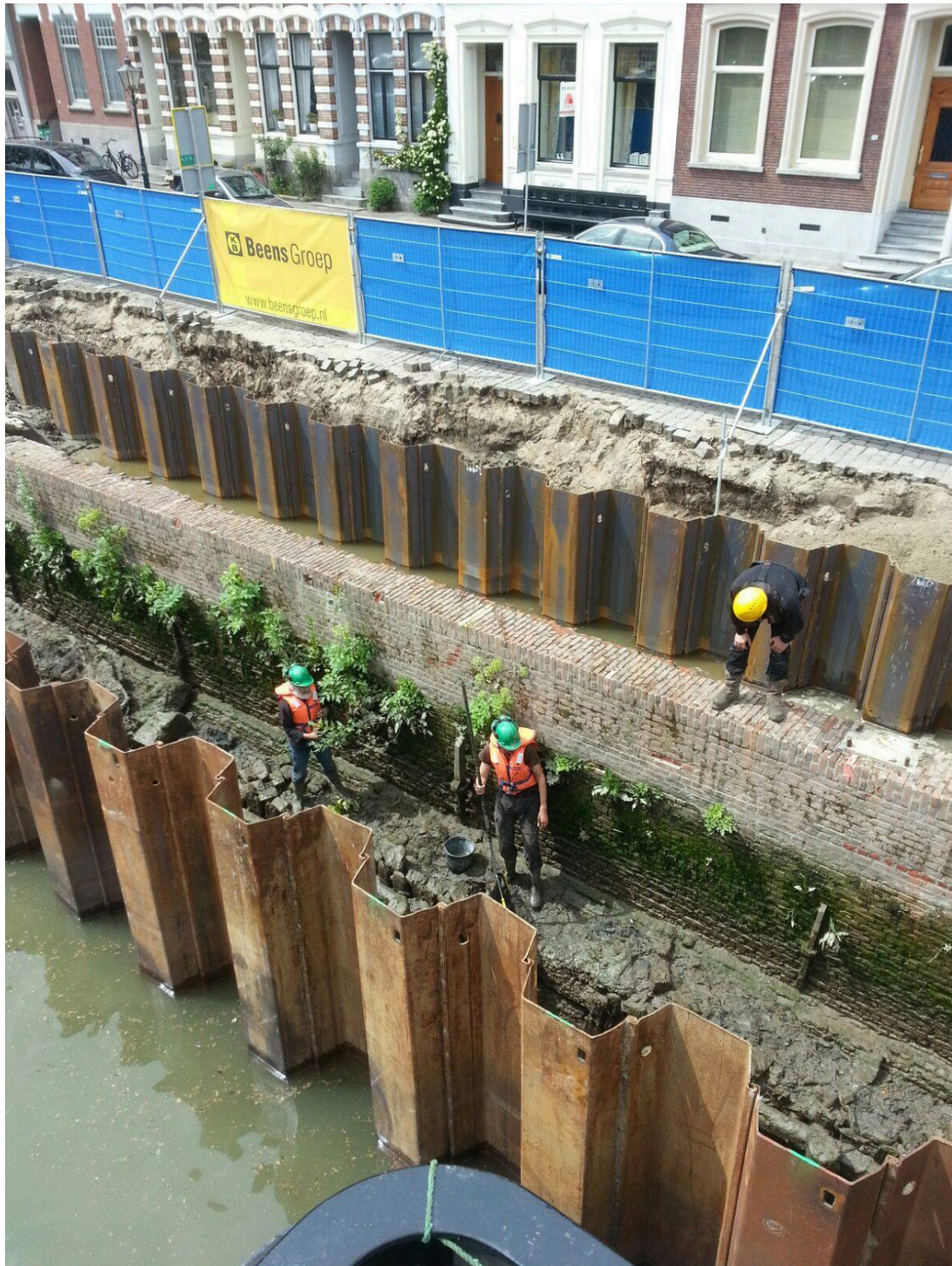
Een deel van het te vervangen stuk van de kademuur tussen de damwanden. Voorafgaand aan het droogpompen van de werkput worden waterdieren gevangen en weer in de haven uitgezet.
