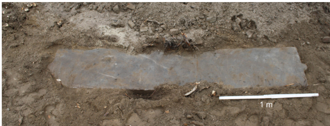
Afb. 10. Eén van de natuurstenen sluitbandblokken van de kadefase uit 1872, aangetroffen in het zandpakket achter de jongste kademuuraanpassing van 1993.
