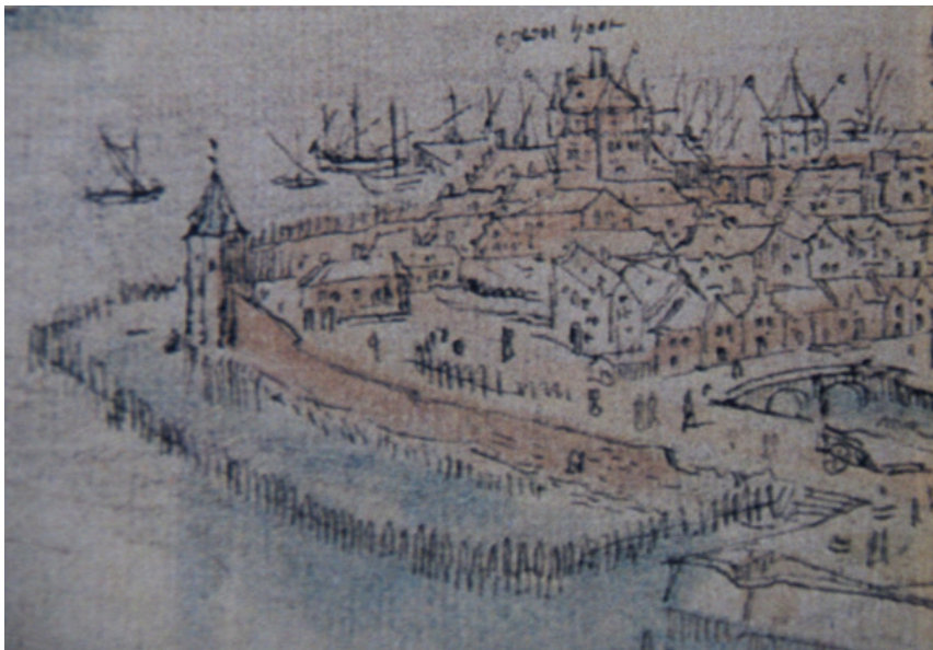
Afb. 4. Het gebied van de latere Wolwevershaven op een uitsnede van een tekening van Anthonis van den Wyngaerde uit (waarschijnlijk) 1544. Hierop is de houten palissade goed te zien. Deze zal zijn aangebracht om zand, slib en opgeworpen grond en stadsafval vast te houden. Het noorden is onder.
