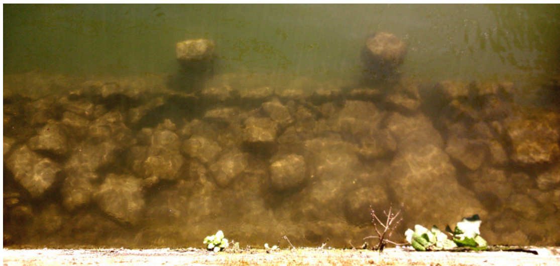
Afb. 7. De teenwand uit 1906 in het water van de Wolwevershaven. Geheel onder is de rand van de kade te zien (Uit: Van Dijke & Hilgers 2014, figuur 4).
