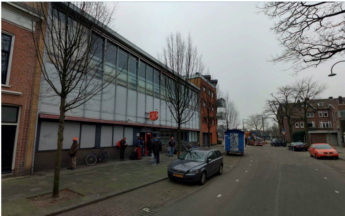
Een deel van het plangebied in maart 2016, gezien tegen de gevel van het pand Dubbeldamseweg Noord 50.
