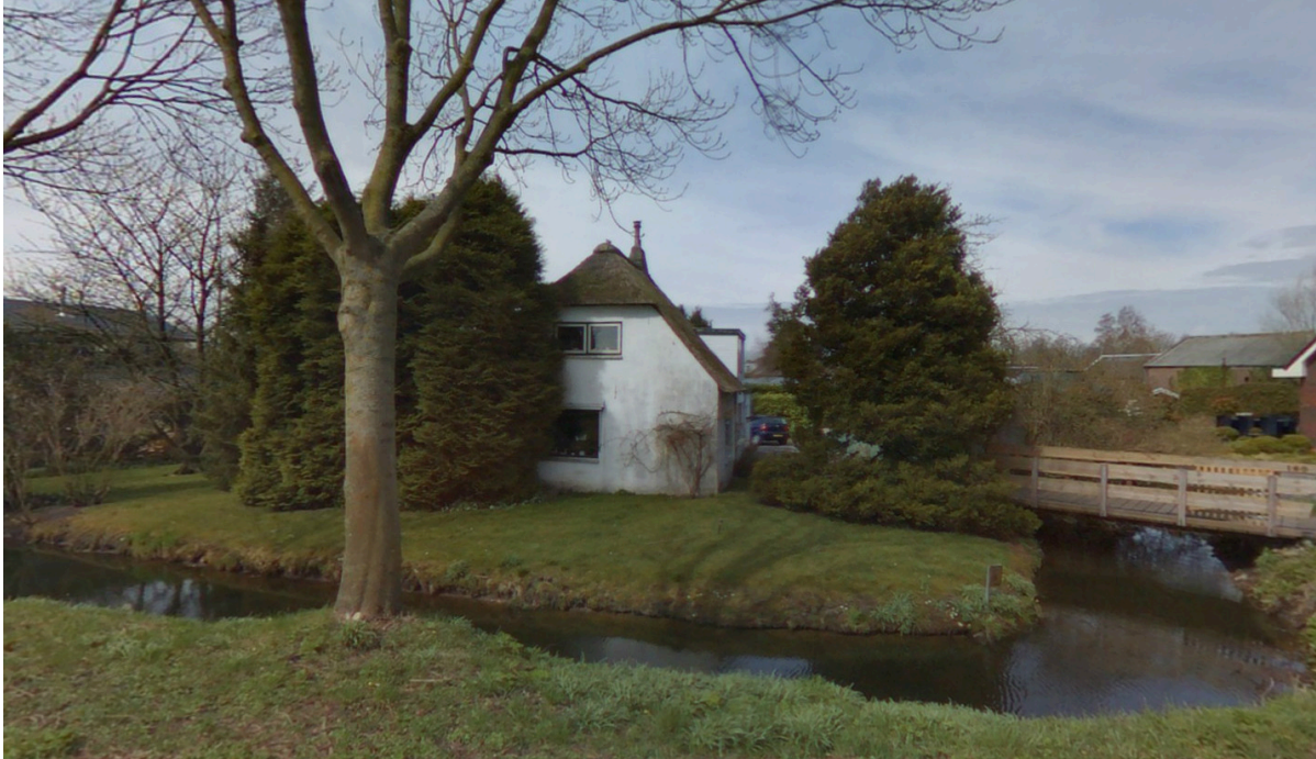
Afb. 10. De recent gesloopte bebouwing aan de Oudendijk 160 in 2013. In het casco kunnen nog 17 e eeuwse delen aanwezig zijn geweest.
