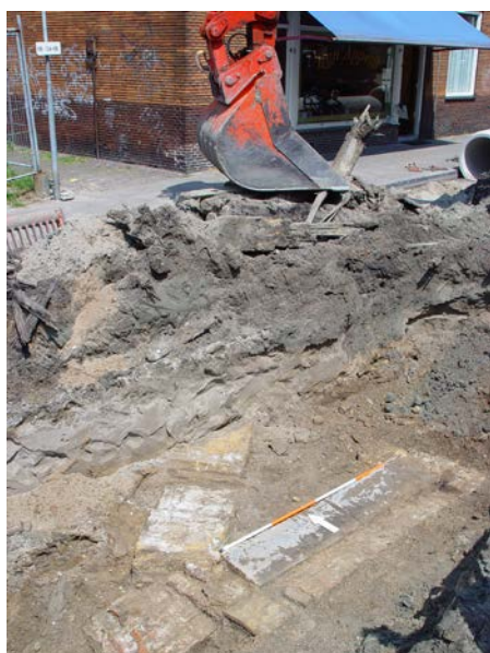
Afb. 11. Het restant van het zuidelijke bruggenhoofd over de binnengracht, gezien vanuit het zuidwesten in de richting van het Hilstraatje (op de achtergrond) die de verbinding vormde naar de Lange Breesstraat.
