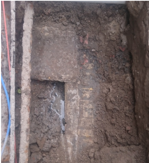
Afb. 10. Deel van goot S2 in de Nieuwstraat tussen de Museumstraat en de Augustijnenkamp, gezien van boven.
