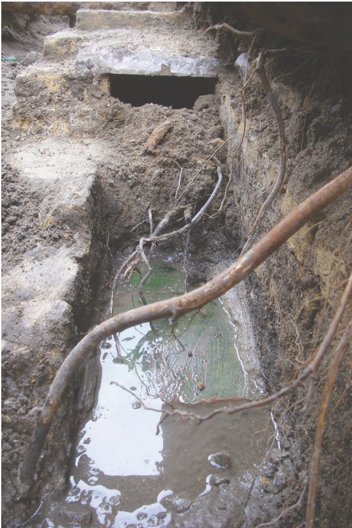
Een deel van het 17e -eeuwse riool onder de stoep van de Nieuwstraat
