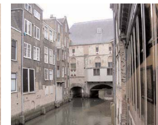
Zicht op de Voorstraatshaven
