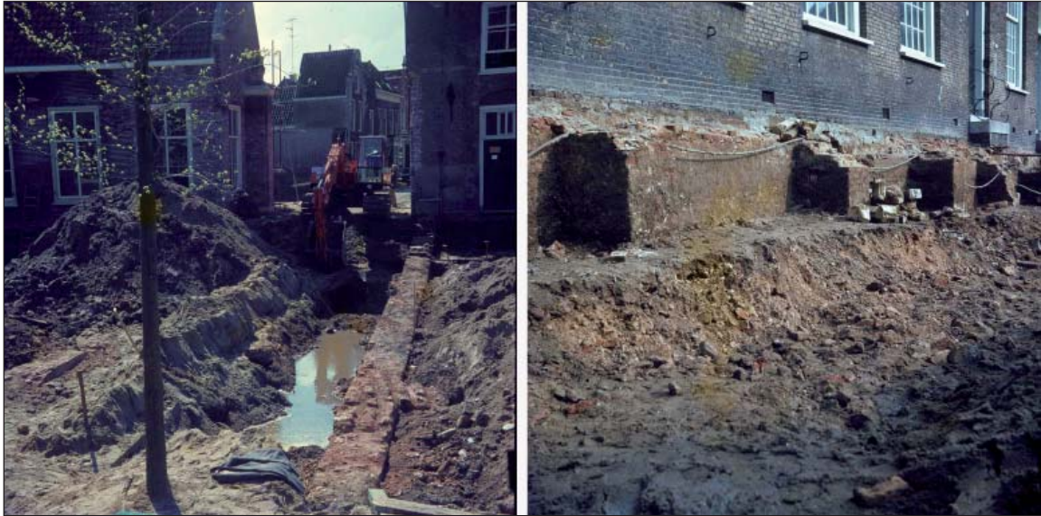
Afb. 6. Enkele details van de werkzaamheden in 1972. Links de ontgraving binnen de fundering van het oostelijk deel van de kloosteromgang van vóór 1512. Rechts: Het plein is ontgraven en biedt zicht op de steunberen van de kloosteromgang van ná 1512. Ook is er een stapel (gotische?) natuursteen bouwelementen te zien; vermoedelijk verzameld uit de afbraaklaag van het klooster na de brand in 1512 (collectie RAD, inventarisnr. 951_2232 en 951_2230).
