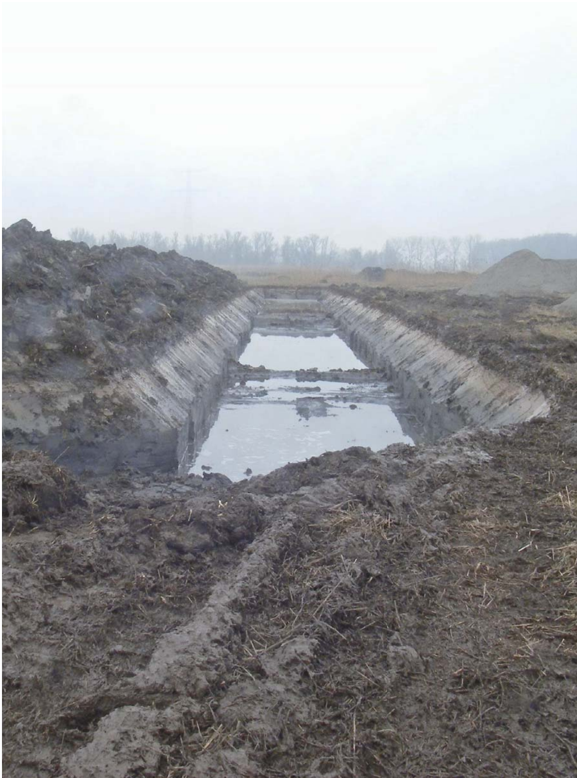
Een deel van de nieuwe, oostelijke kwelsloot rond de Stort van Troost in de polder Stedelijk (foto: gemeente Dordrecht, Ruimtelijke Realisatie/archeologie april 2015).
