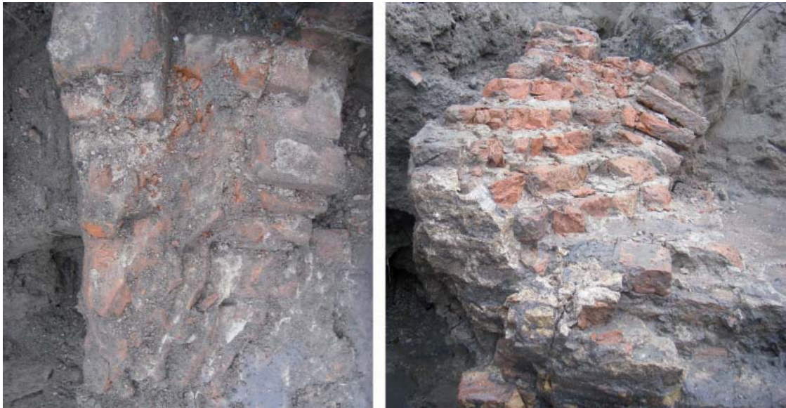
Afb. 17. Zicht op de bovenzijde van de steunbeer met spaarboog (links) en vanaf de buitenzijde van de muur (rechts).
