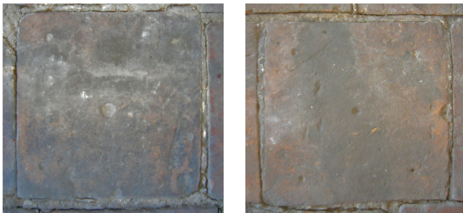
Afb. 10. Details van enkele van de plavuizen met de karakteristieke putjes in het centrum en de vier hoeken van de tegel.
