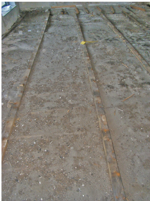
Afb. 17. Het zandpakket zoals dat zichtbaar werd na het verwijderen van de houten vloer, gezien in de richting van de oostelijke zijmuur.
