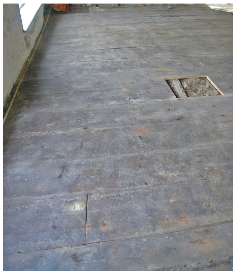
Afb. 15. Deel van de houten vloer in het oostelijk deel van de 1 e verdieping. Onder is een detail weergegeven waarop de dichtgezette kieren te zien zijn.
