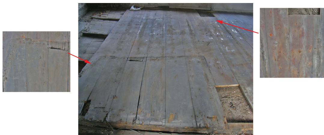
Afb. 16. De houten vloer in het westelijk deel, met vuile strepen en - op de voorgrond - de omlijning van een meubelstuk op de vloer. In de details zijn delen van bovenaf weergegeven.
