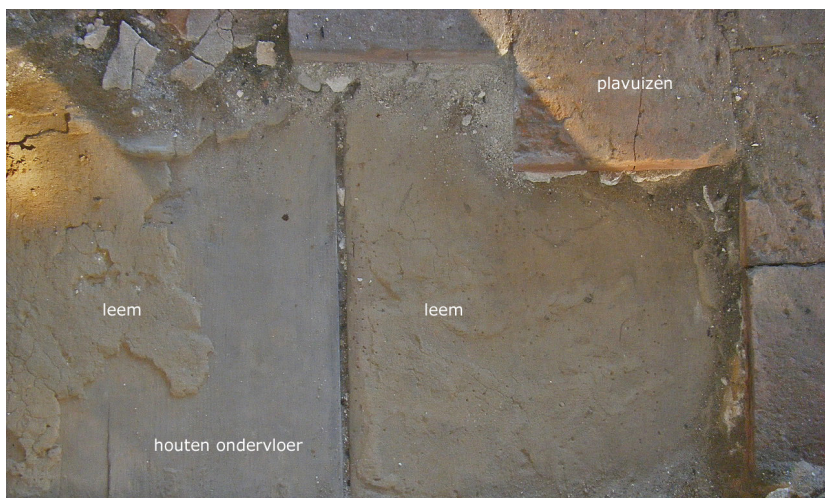
Afb. 9. Resten van de leemlaag op de houten ondervloer onder de plavuizenvloer.
